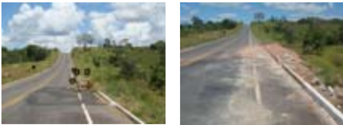
Figura 6.13 – Reconstrução de segmento – km 34- lado esquerdo (foto 1 – março, foto 2 – abril/2010).
