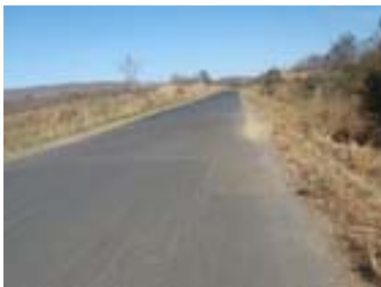
Figura 5.10 – Detalhe do aterro escolhido para execução do ensaio.
