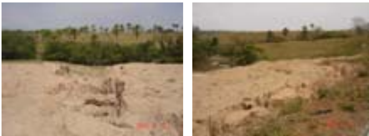
Figura 6.11– Disposição inadequada de bota-fora, causando assoreamento de drenagem natural, foto 2005.
