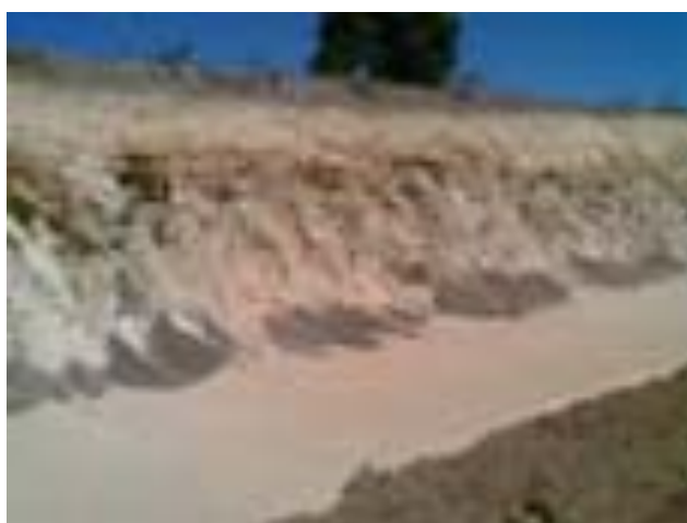
Figura 3.5 – Detalhe do processo de solifluxão em talude da rodovia BR-080/GO, km 42, em 2010.
