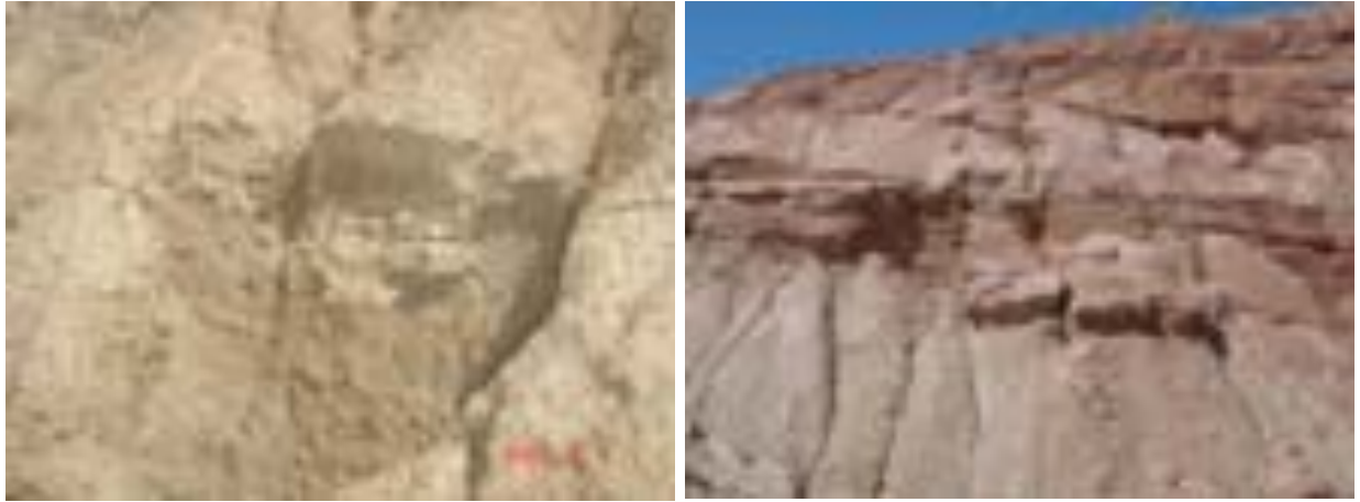
Figura 6.6 – Processo de empastilhamento em talude de corte.
