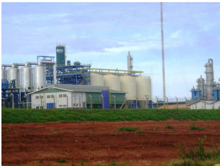
Figura 2 - Instalações industriais da ETH Bioenergia Unidade Morro Vermelho.
