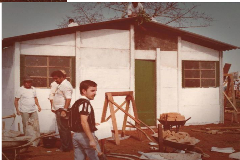
Figura 15: Casa construída na Vila Mutirão, 1983. Fonte: Programa Goiás de Norte a Sul, 2015.
