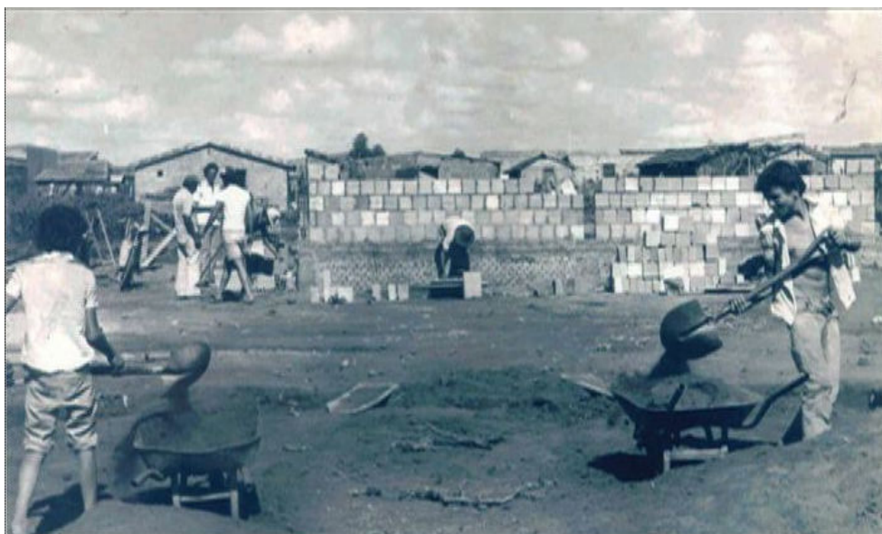
Figura 9: Construção de casas de alvenaria na ocupação do Jardim Nova Esperança em 1980. Fonte: Programa Goiás de Norte a Sul, 2015.
