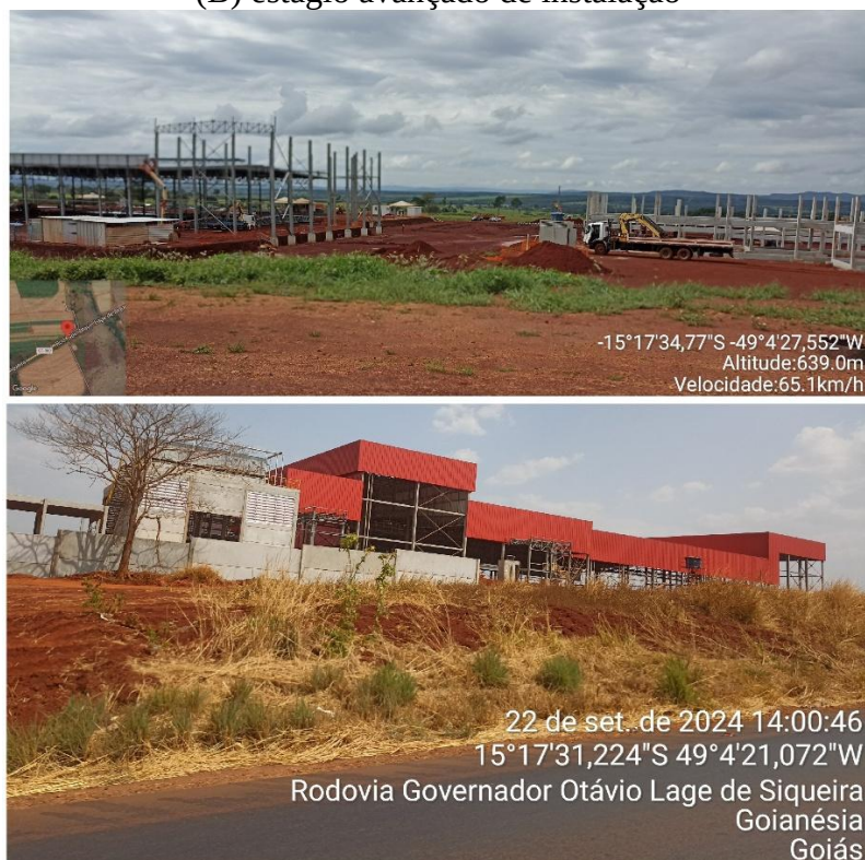
Figura 35: Implantação de unidade industrial (Frico) na BHRF: (A) fase inicial de construção; (B) estágio avançado de instalação
