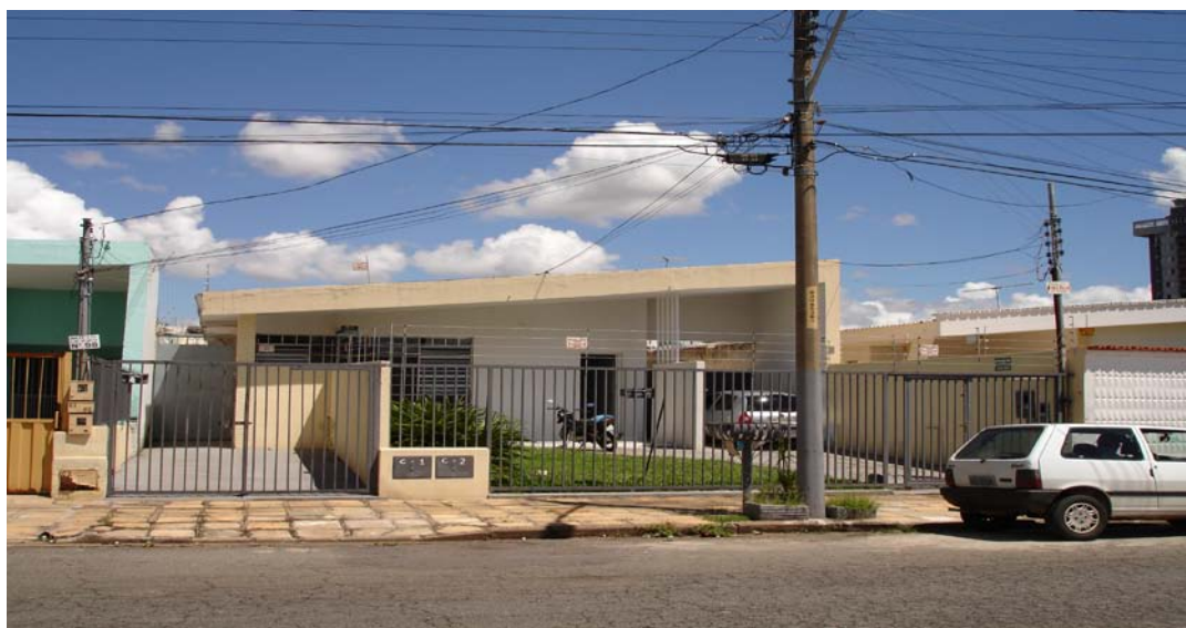
Figura 19: Residência Rua R-6, Goiânia. Fonte: Roriz Júnior, 2006.
