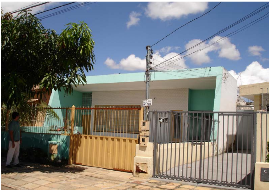
Figura 21: Residência Rua R-6, Goiânia. Fonte: Roriz Júnior, 2006.
