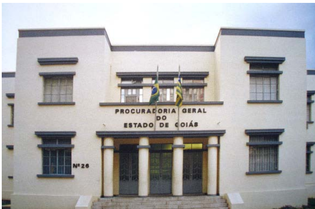
Figura 31: Prédio da Procuradoria Geral do Estado de Goiás Fonte: Unes, 2006
