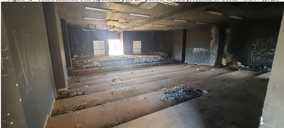
Figura 42 - Teatro/auditório com capacidade para 237 pessoas da PEC produzida no Buena Vista IV (2025)
