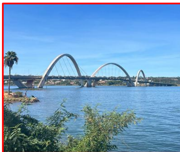
Figura 8 – Ponte JK. Brasília-DF
