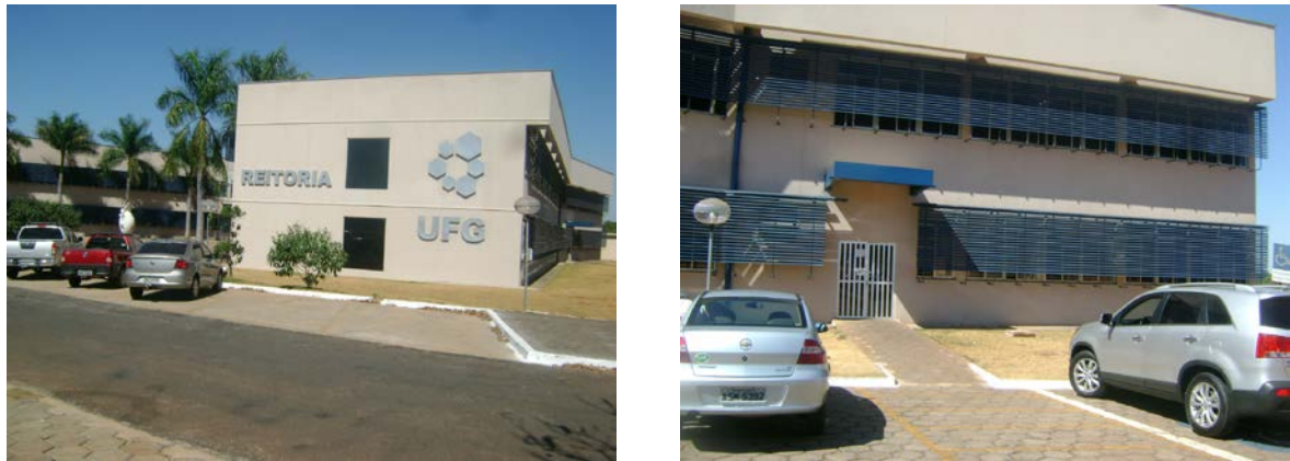
Figura 4. 2: Vista externa da edificação.
