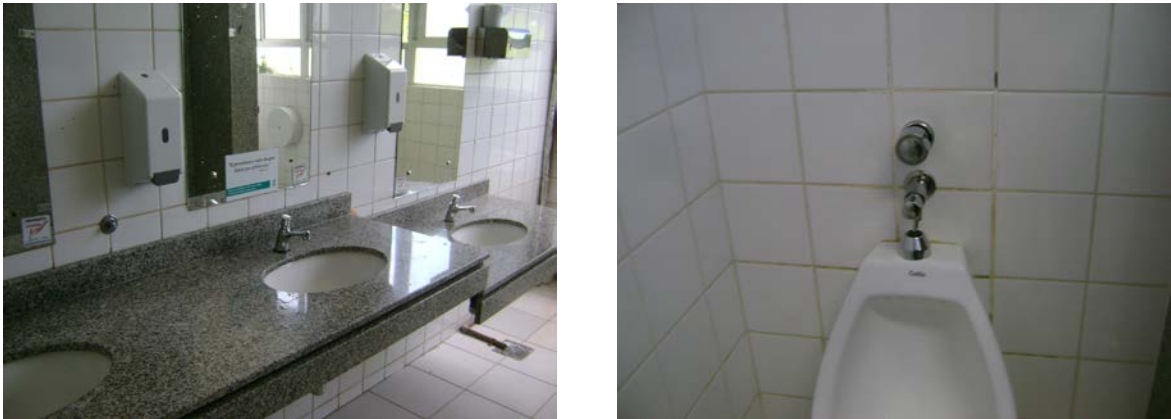
Figura 4. 14: Aparelhos sanitários depois da substituição.
