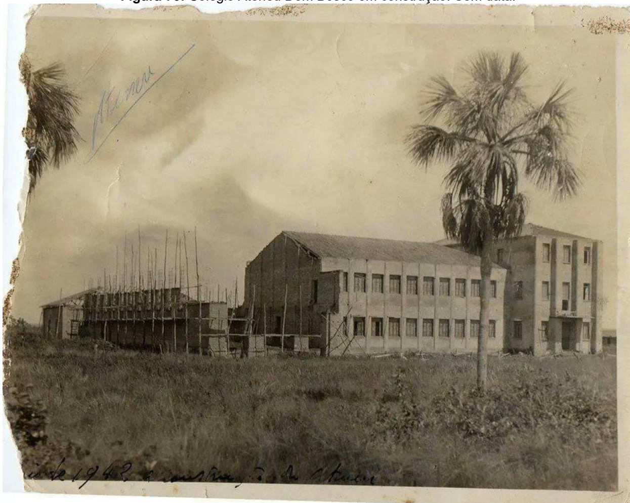
Figura 70: Colégio Ateneu Dom Bosco em construção. Sem data.
