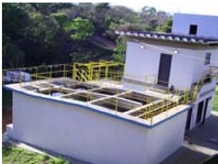
Figura 12 – Vista geral da ETA ciclo completo de Goianópolis
