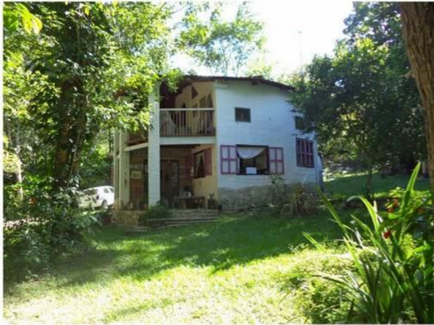
Figura 23 – Refúgio 5 - Casa Octogonal – registro em abril de 2017
