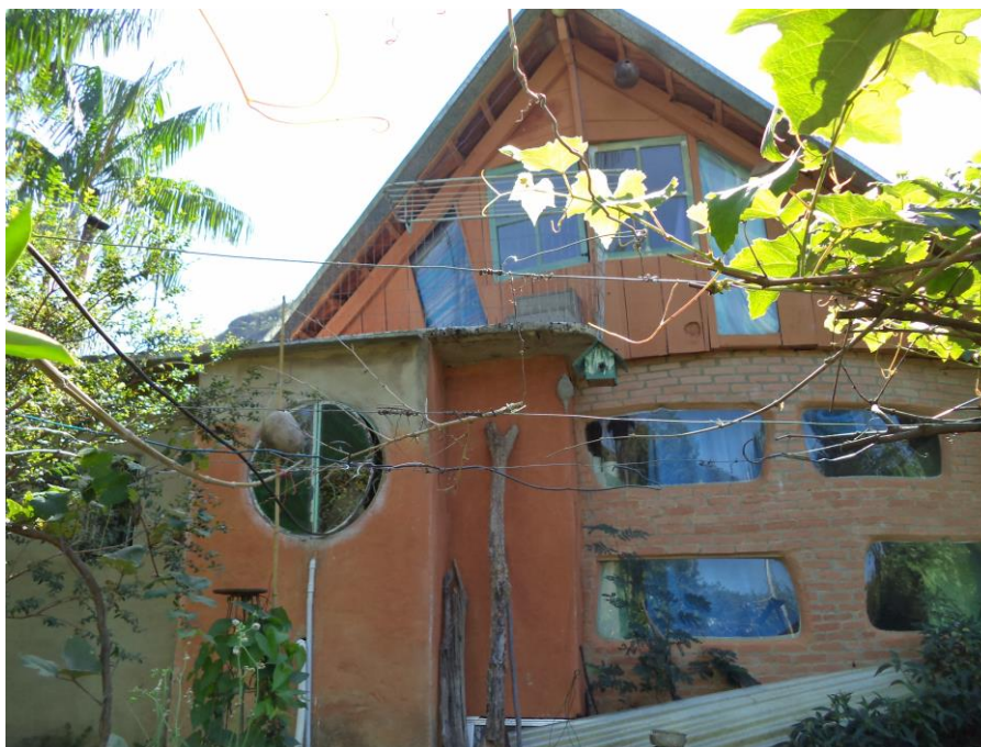
Figura 67 – Casa Circular e o anexo construído posteriormente
