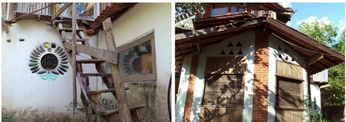
Figura 31 – Paredes com aberturas em desenhos geométricos – registro em junho de 2016
