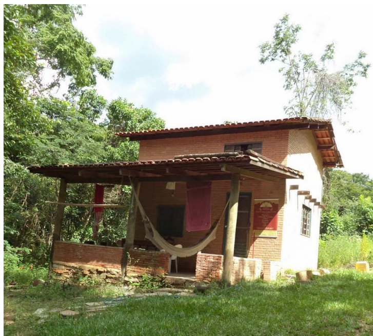
Figura 68 – Refúgio 7 - Casa Chalé – registro em abril de 2017
