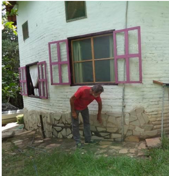
Figura 89 - Otacílio mostrando como revestiu a casa com pedras – abril de 2017
