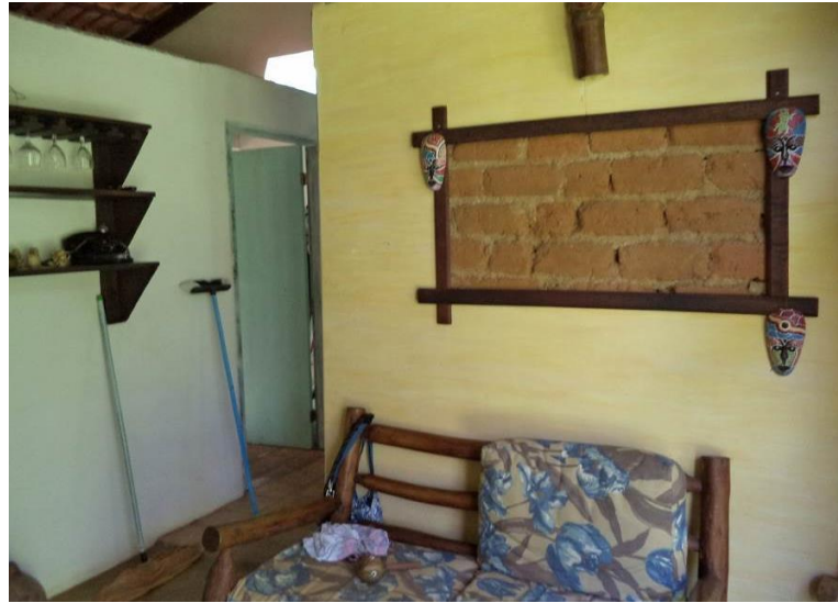
Figura 36 – Exposição da parede transformado em elemento decorativo – registro em junho de 2016
