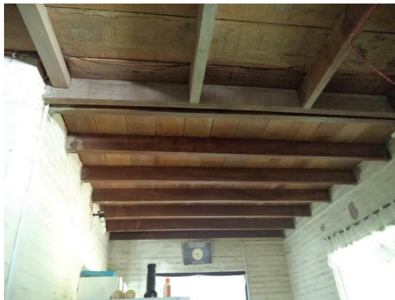
Figura 80 – As tábuas que formam o primeiro pavimento vistas do térreo – abril de 2017
