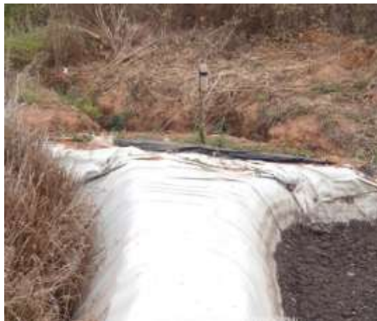
Figura 4.11: Pluviômetro instalado no sistema experimental.
