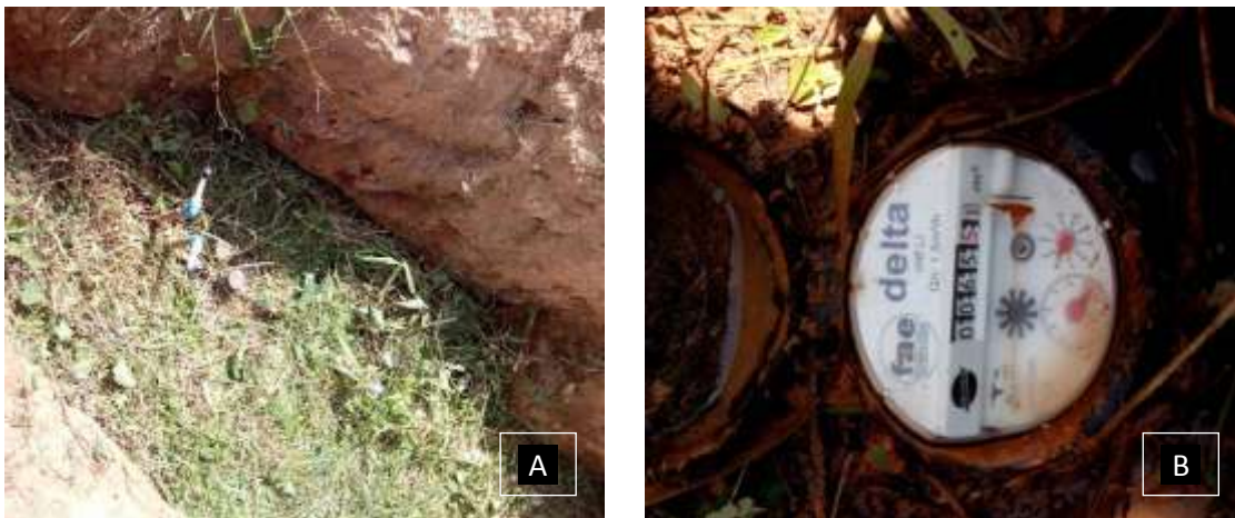
Figura 4.12: (A) hidrômetros implantados na parte externa do sistema de drenagem dos tanques; (B) hidrômetro em detalhe.
