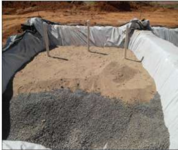
Figura 4.5: Detalhe do preenchimento dos tanques de tratamento com substrato em camadas sobrepostas.
