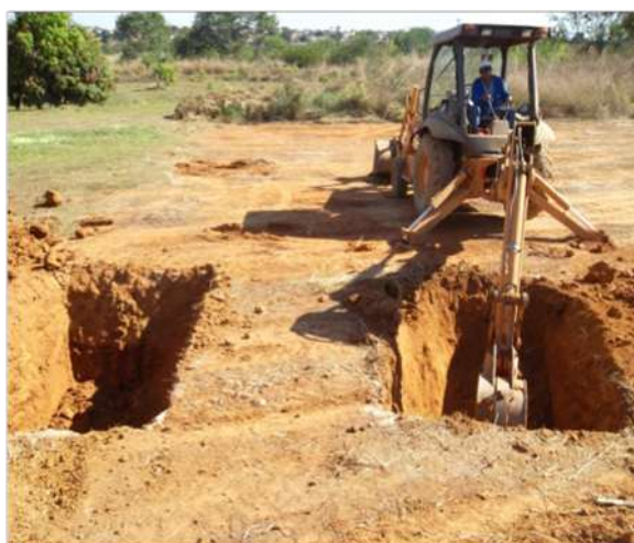
Figura 4.2: Início de escavação dos tanques do sistema experimental.
