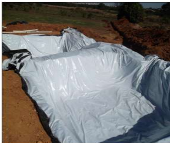
Figura 4.3: Posicionamento da manta de impermeabilização nos tanques de tratamento do sistema experimental.
