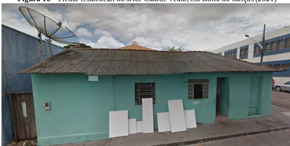
Figura 16 – Prédio residencial no setor Cidade Velha, em Barra do Garças (2021)
