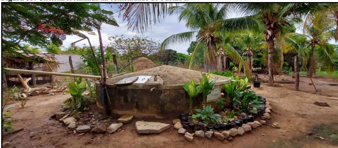
Figura 35: Cisterna localizada na comunidade do Fabião I.
