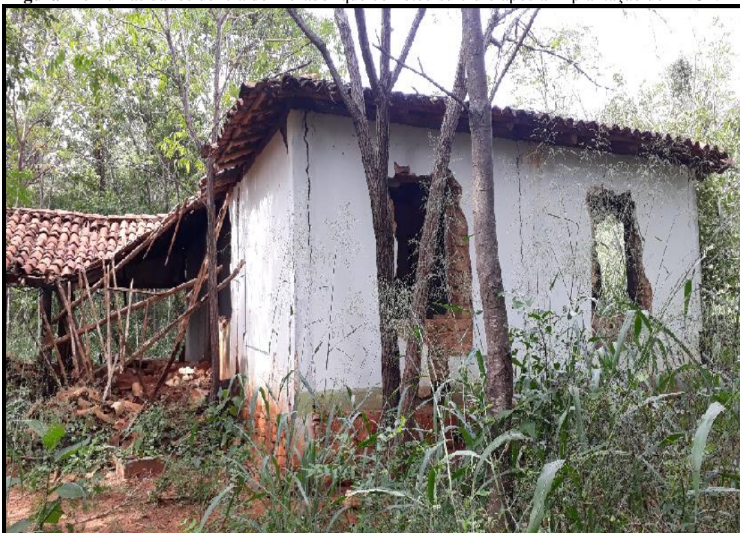
Figura 12: Ruínas da residência do morador que cometeu suicídio após a implantação do PNCP.
