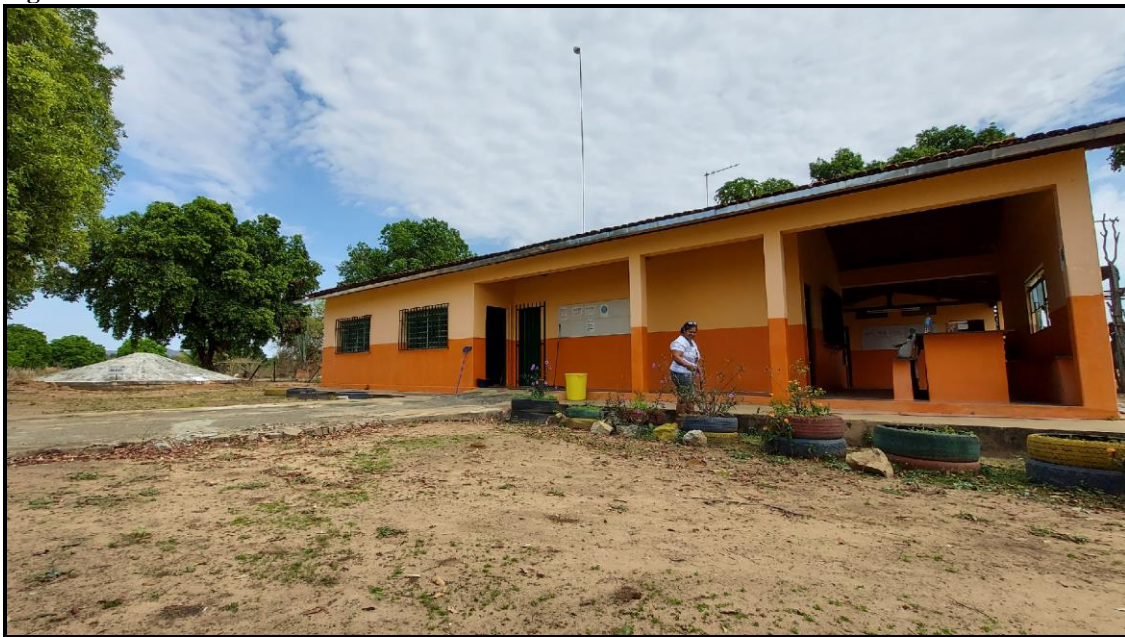
Figura 31: Extensão da Escola Estadual do Fabião I na comunidade do Retiro.
