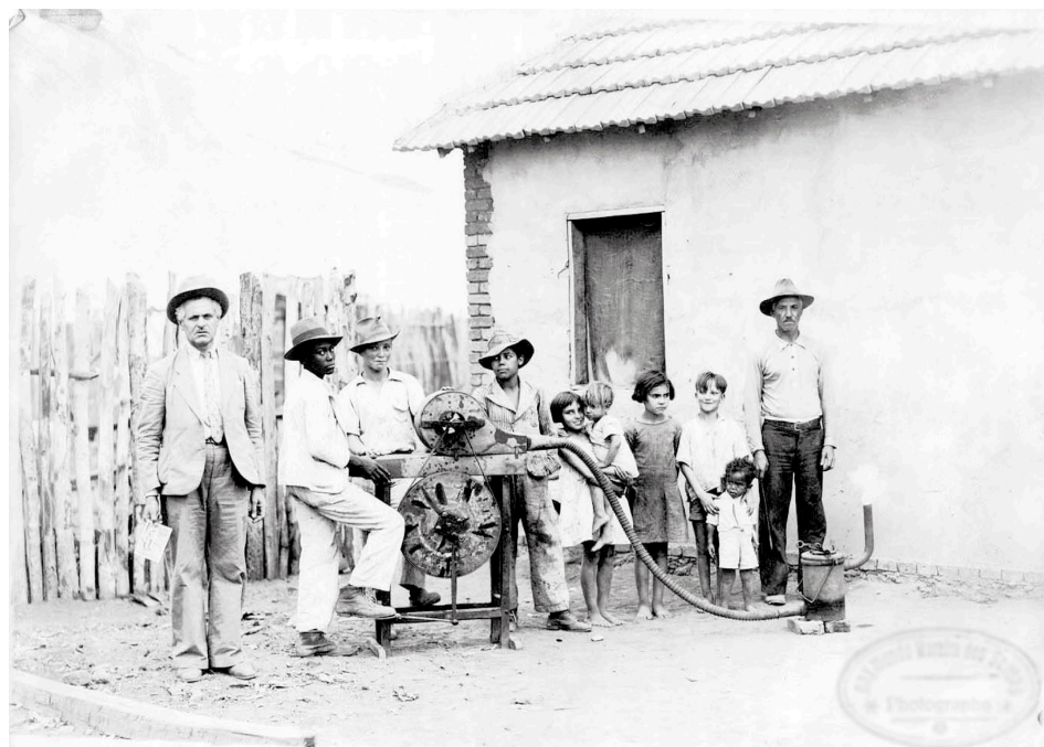
Fig. 16 - Fotográfica “Máquina de matar formigas 'Turba', inventada por Caran Zancul (à esquerda)”. Fonte: CPDOC Fundação Getúlio Vargas.
