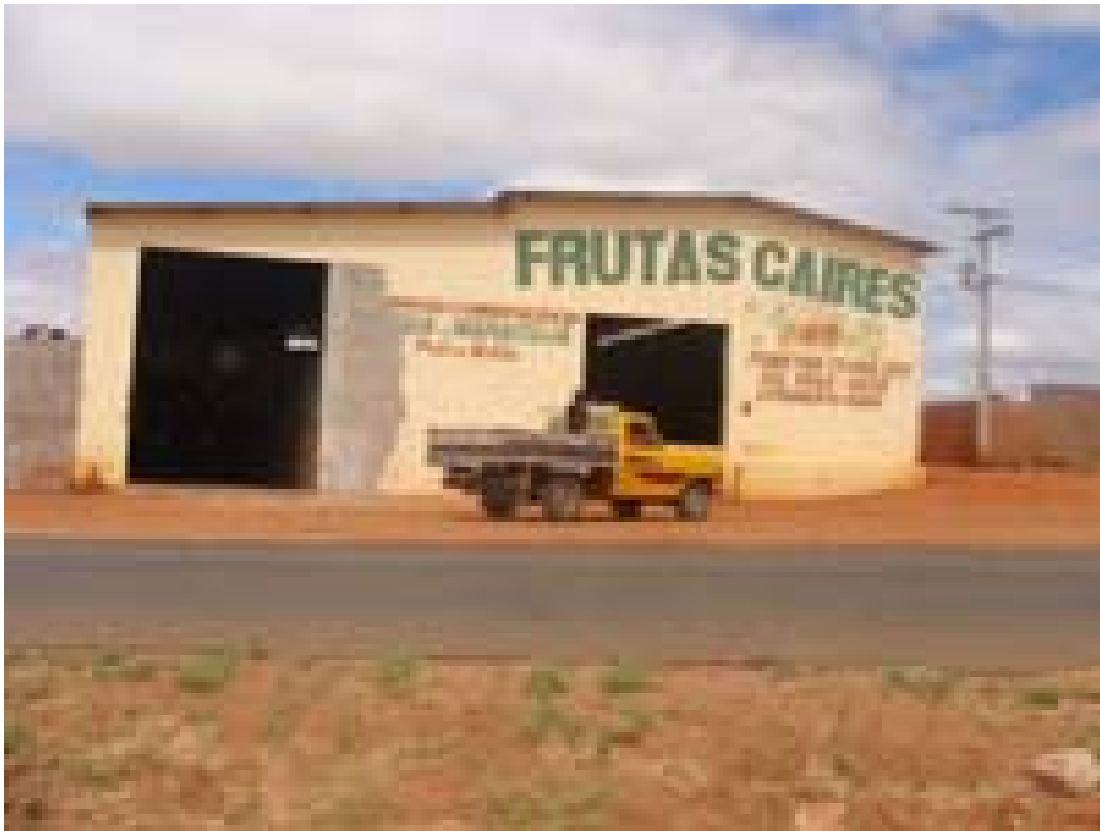
Foto 13 – Galpão localizado às margens da Rodovia BA-148, no Bairro Piçarrão. Trata-se de um galpão com boas instalações, sendo um dos maiores da cidade. Livramento de Nossa Senhora (BA). Fonte: Trabalho de campo, set./2010. Autor: DOURADO, J. A. L.
