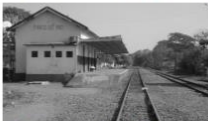
Estação ferroviária desativada, em Feres do Rio
