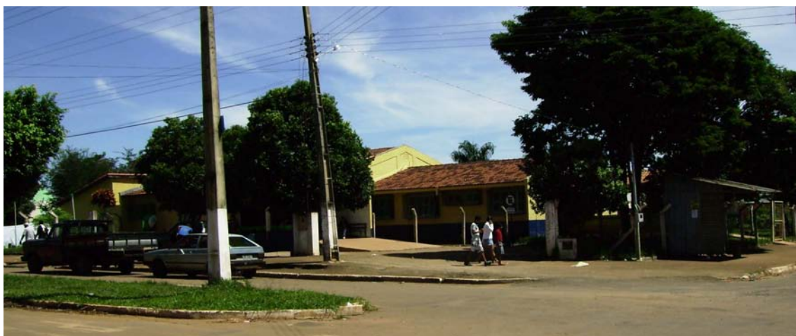
Figura 35 – Hospital público do município de Goianira – 2009.
