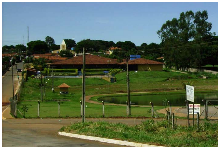
Figura 34 – Centro Escolar de Educação Física do município de Goianira – 2009.
