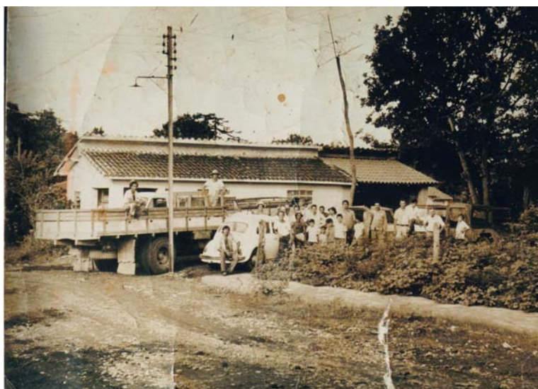
Figura 12 – Mutirão para cascalhamento da Avenida Central (atual Avenida Goiás) – 1972.
