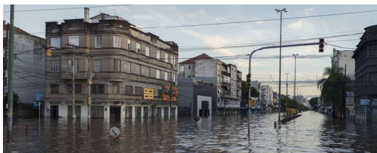
Avenida Farrapos, em Porto Alegre, completamente alagada devido às chuvas - Daniel Marengo
