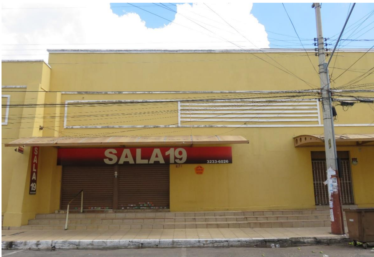
Figura 138 - Fachada da Sala 19 após a requalificação. Fonte: Acervo Daniele Severino, 2017.
