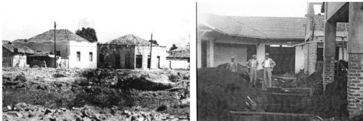
Figura 112 - Casas sendo demolidas para dar início à construção do mercado e construção do Mercado de Campinas em 1954.
