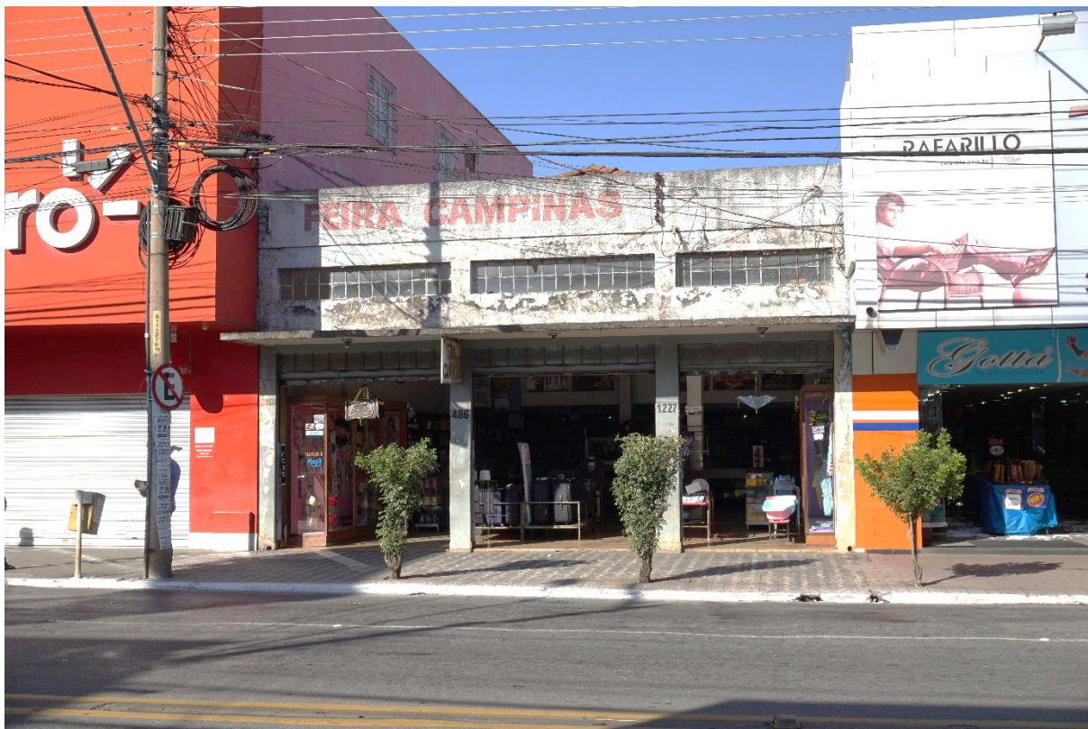
Figura 98 - Fachada da Feira Campinas. Foto: Daniele Severino, 2017.
