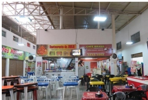
Figura 128 - Estrutura da cobertura após requalificação.
