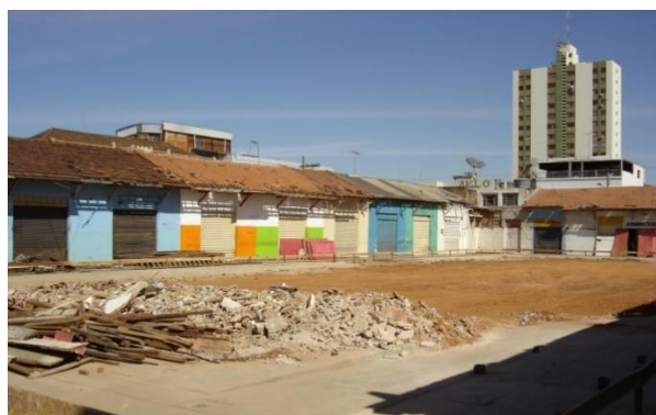
Figura 130 - Demolição das lojas existentes.
