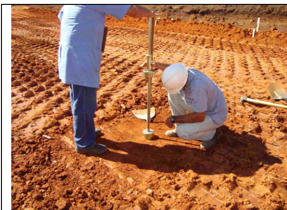
Figura 3.5a Amostragem para determinação do grau de compactação:
