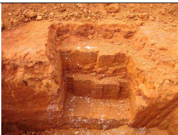
Figura 3.5b Aspecto das camadas compactadas.
