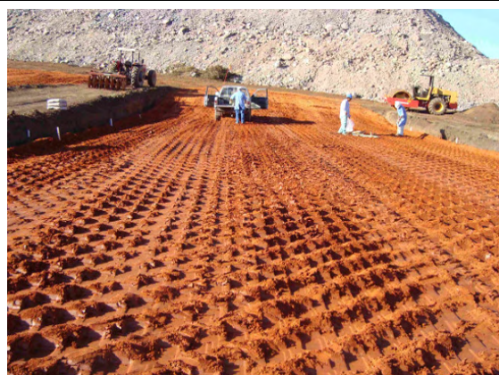
Figura 3.4b. Aspecto do material após compactação de todas as passadas.
