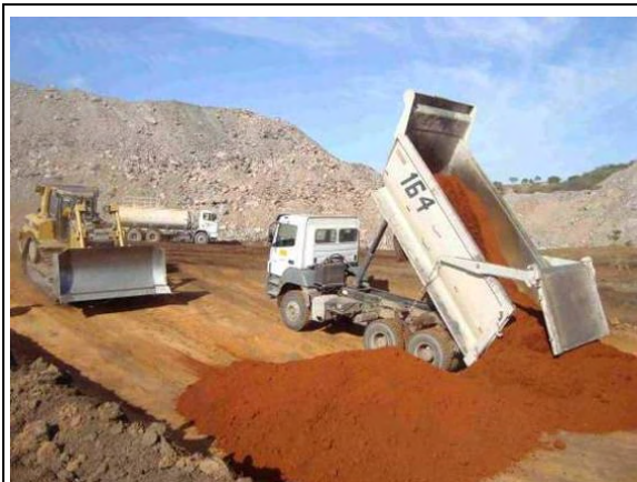
Figura 3.4a. Espalhamento do material do aterro.
