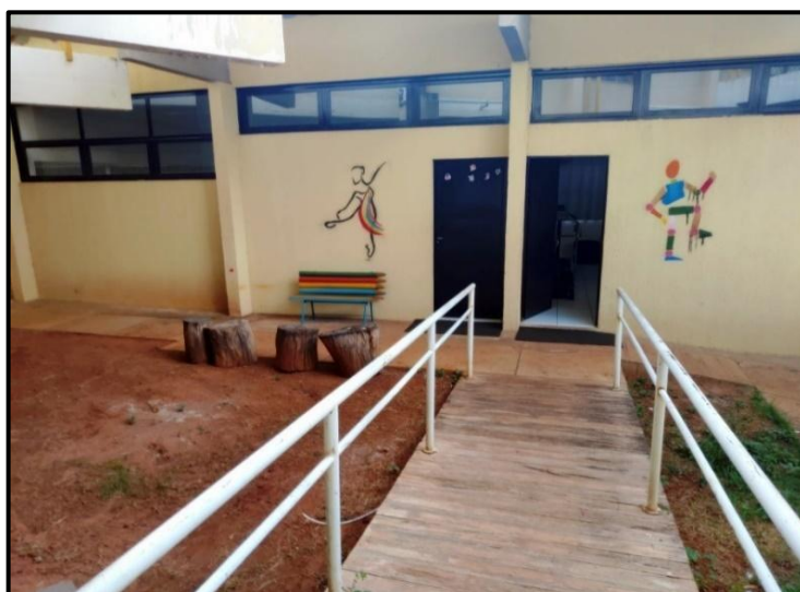
Figura 12 – Acesso às salas de ginástica
