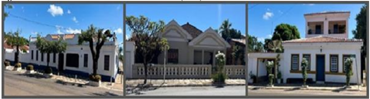
Figura 12 – Casas localizadas na Rua Alto do Rosário (2024).
