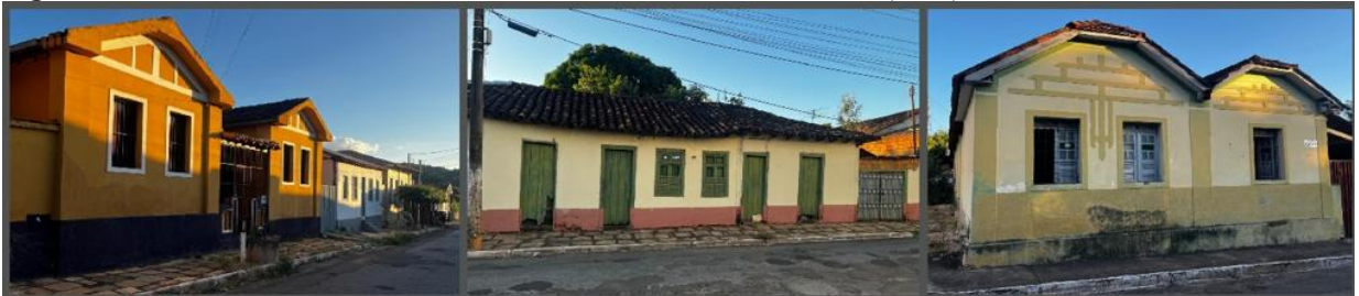
Figura 17 – Casas localizadas na Rua Manoel Marcelino Álvares da Silva (2024).
