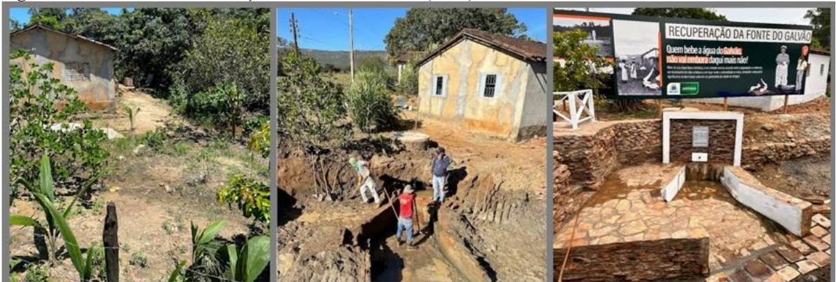
Figura 9 – Processo de revitalização da Fonte do Galvão (2023).
