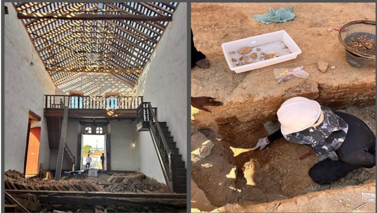
Figura 27 – Processo de restauração e intervenção arqueológica na Igreja Nossa Senhora do Rosário (2024).
