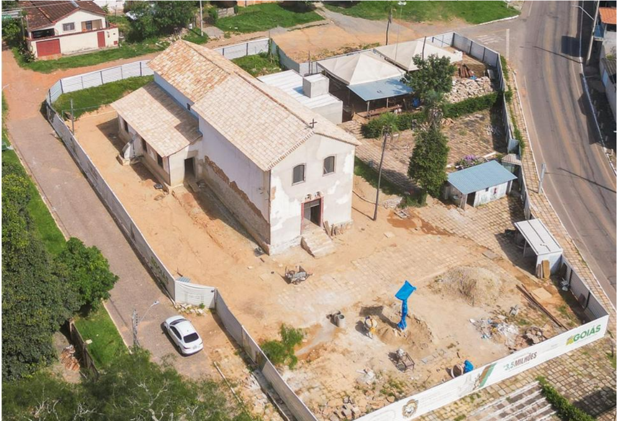
Figura 28 – Igreja Nossa Senhora do Rosário – obras em fases de finalização (2025).
