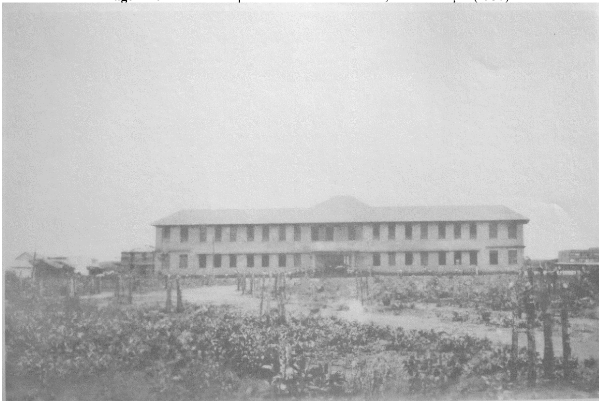
Imagem 20 - Fachada do prédio do Liceu de Goiânia, em construção (1937)
