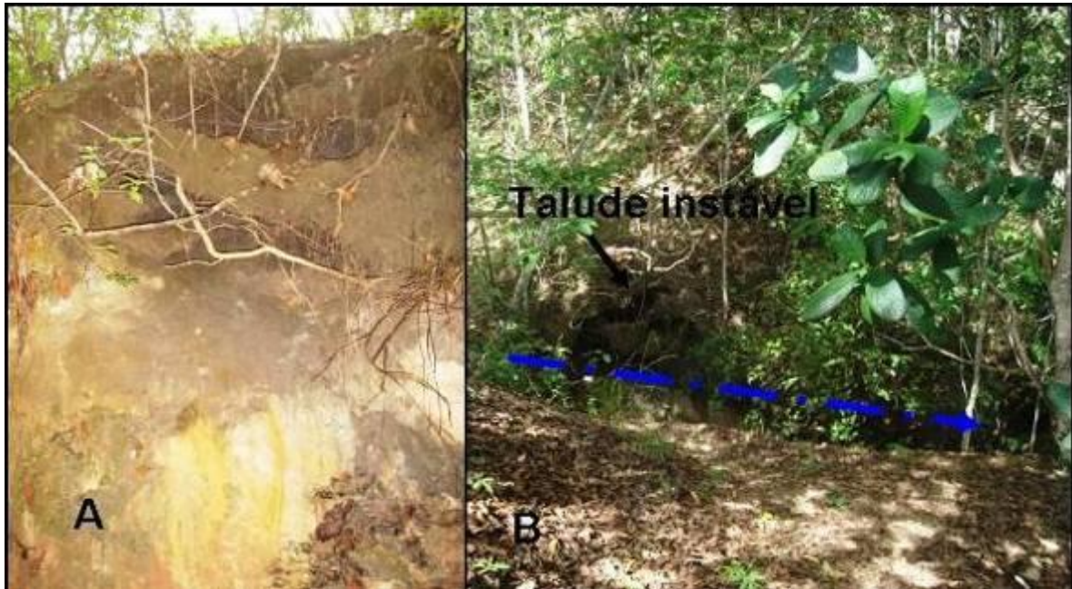
Figura 48. A e B Solapamento do talude no trecho inferior da voçoroca em área parcialmente estável (presença de vegetação – repovoamento espontâneo).
