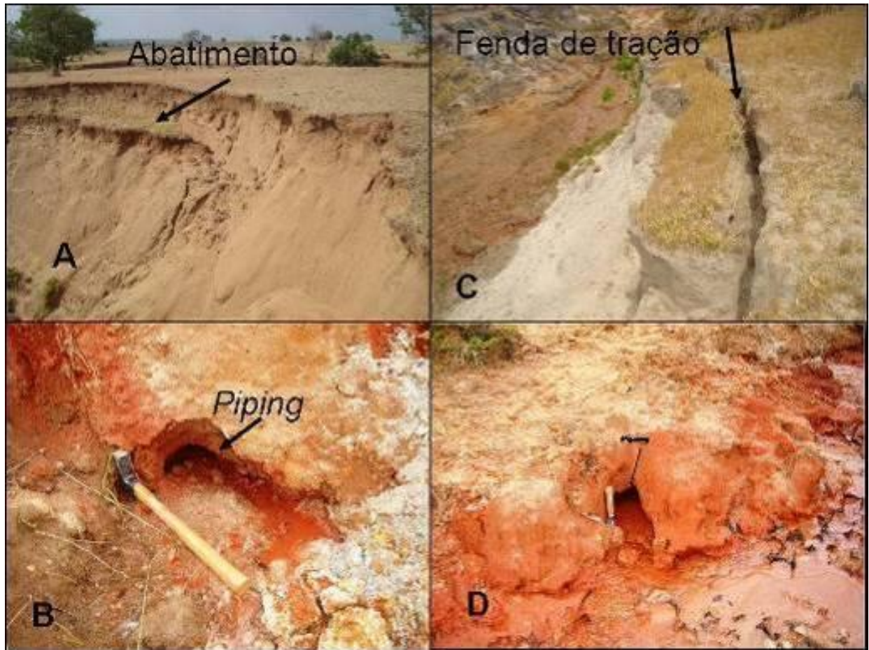
Figura 31. Mecanismos erosivos atuantes. A. Abatimento na cabeceira; B. Piping com desabamento recente do teto no horizonte C; C. Fenda de tração no talude direito D. Piping com teto relativamente preservado, (SOUSA, 2008).
