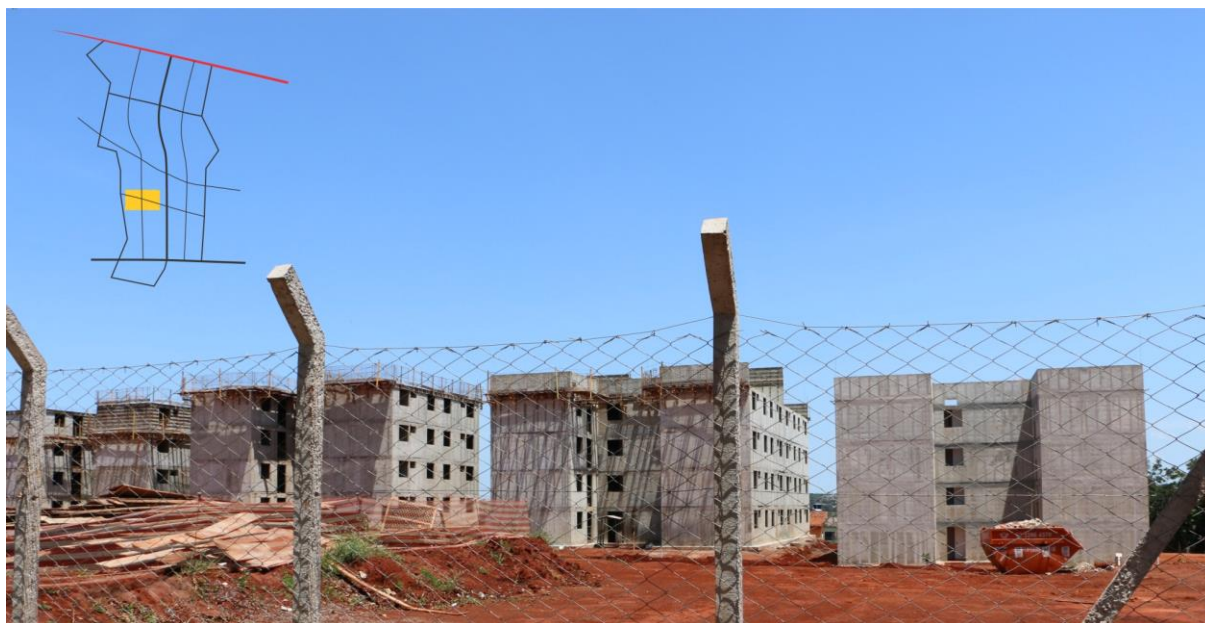
FIGURA 43. Etapa da construção de blocos residenciais no bairro através do programa MCMV. Fonte: dados da pesquisa, fotógrafo: Edinardo Lucas, novembro de 2015
