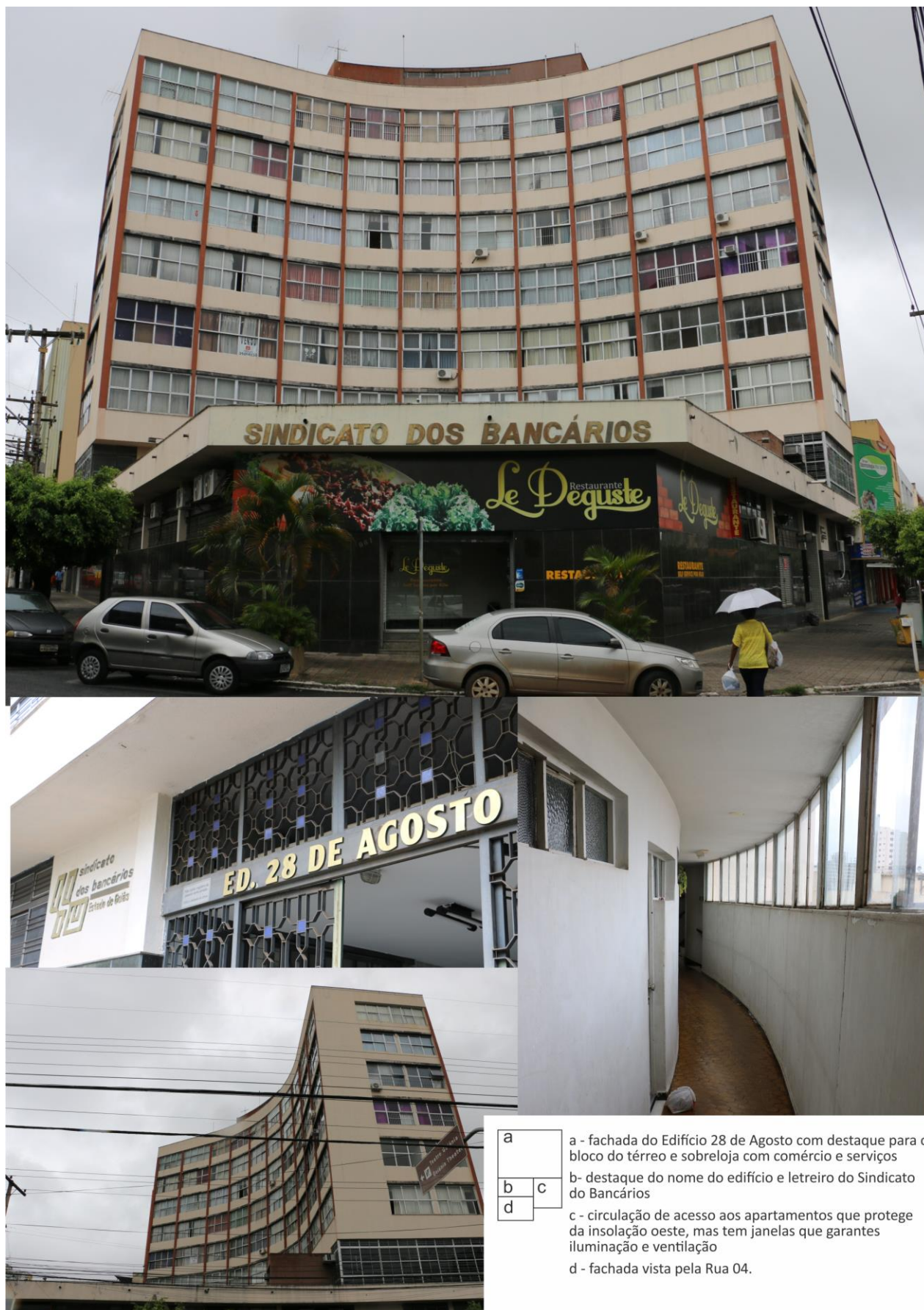
FIGURA 11. Edifício 28 de Agosto: fachadas e corredor de circulação para os apartamentos. Fonte: acervo da pesquisa; fotógrafo: Edinaro Lucas, 2014.
