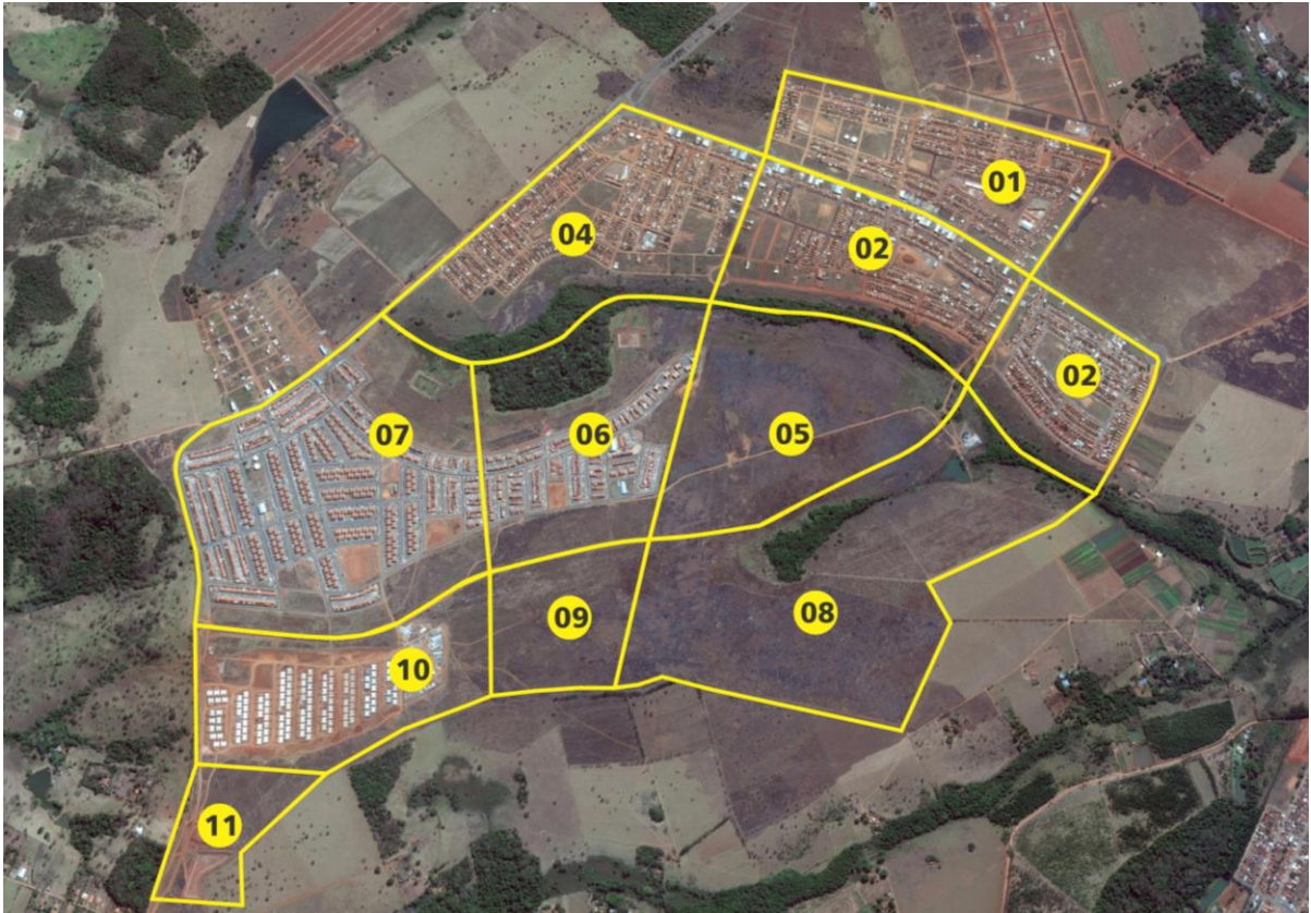
FIGURA 46. Na imagem aérea de 2015 temos a exata percepção das etapas já concretizadas no Residencial Jardim Cerrado. Reprodução modificada para visualização mais didática. Fonte: GOOGLE EARTH, 2015; composição gráfica e diagramação: Edinaldo Lucas, 2015.
