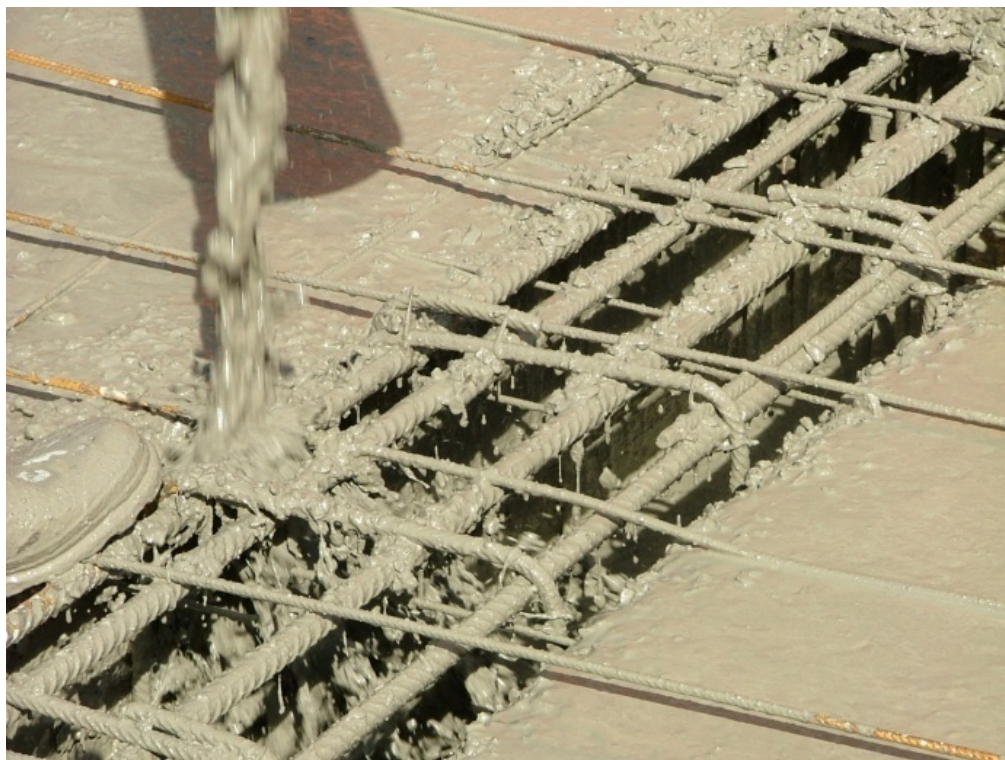
Figura 2. 3 – Concretagem do pavimento tipo de um edifício
