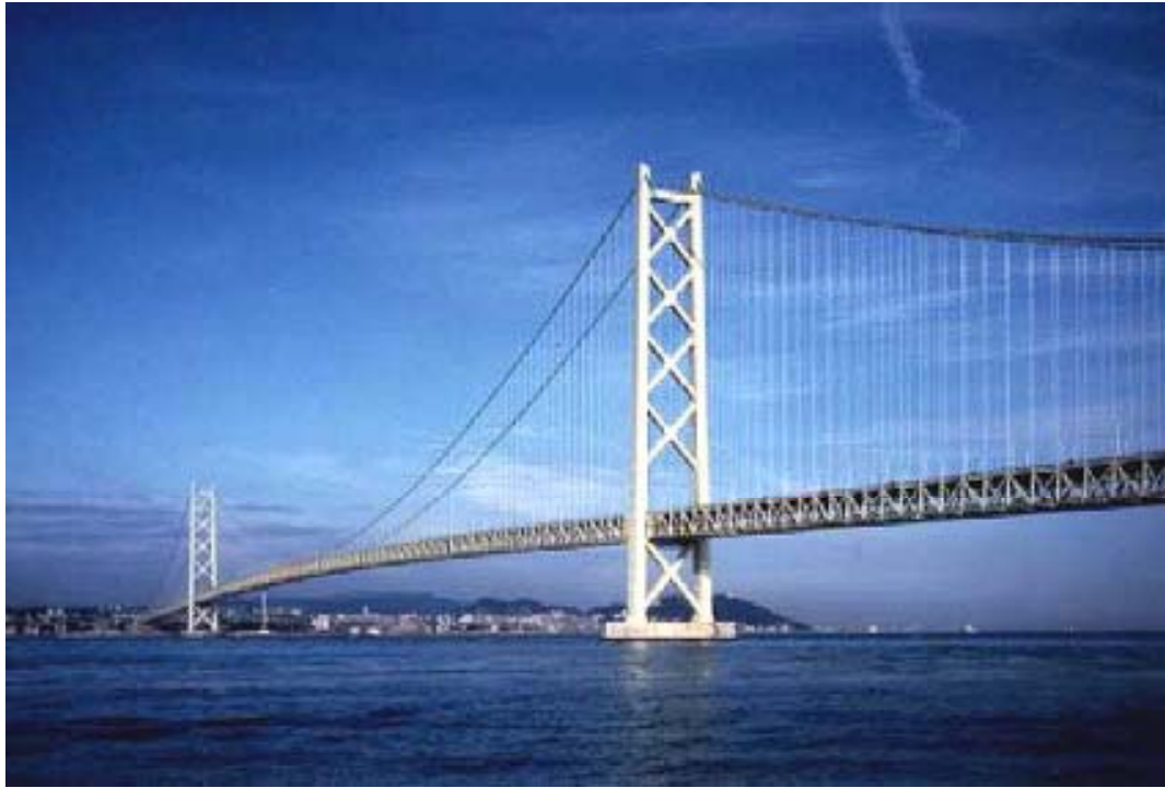
Figura 1. 1 - Ponte Akashi-Kaikyo (Geyer, 2006)
