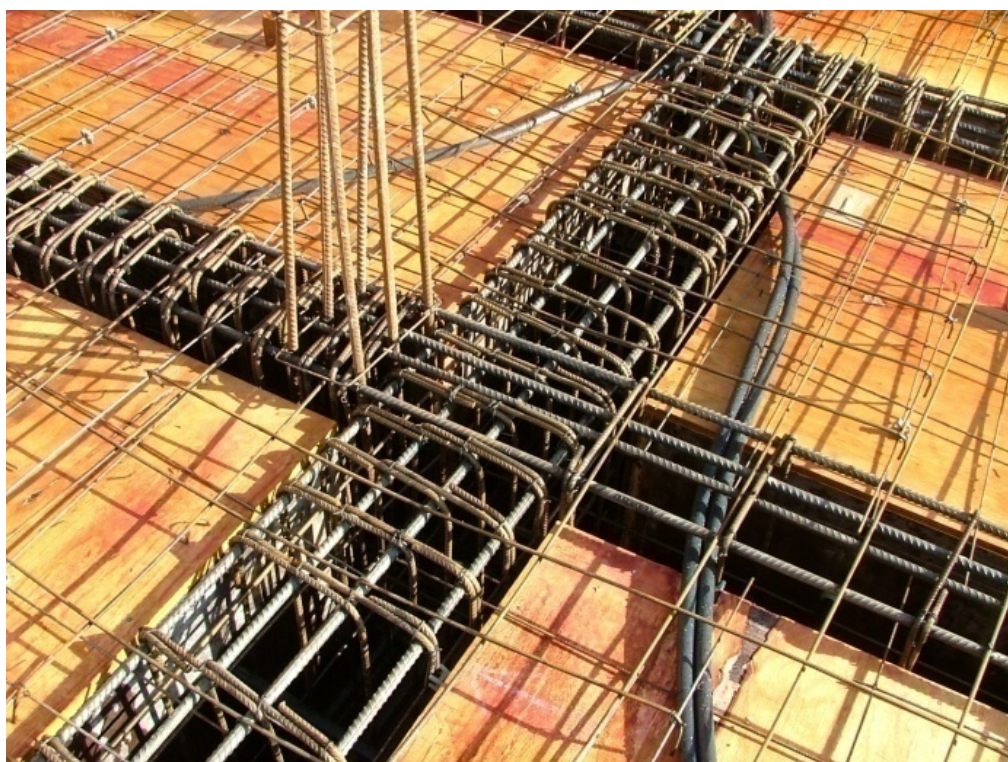
Figura 2. 2 - Detalhe da armadura do pavimento tipo
