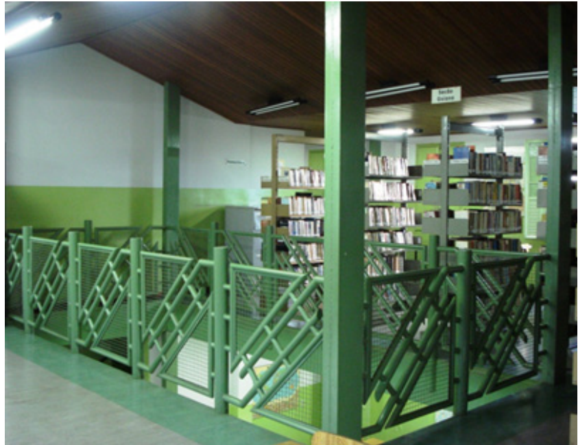
Imagem 80: Guarda-corpo do vão do Pavimento Superior. Fonte: Daniella Moreira Rocha, 2013.
