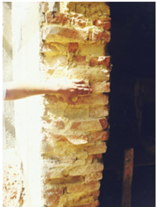
Imagem 71: Alvenaria estrutural, sistema estrutural da década de 1930. Fonte: Arquivo Biblioteca Cora Coralina.
