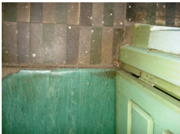
Imagem 73: Piso original em ladrilho hidráulico na sacada. Fonte: Daniella Moreira Rocha, 2013.
