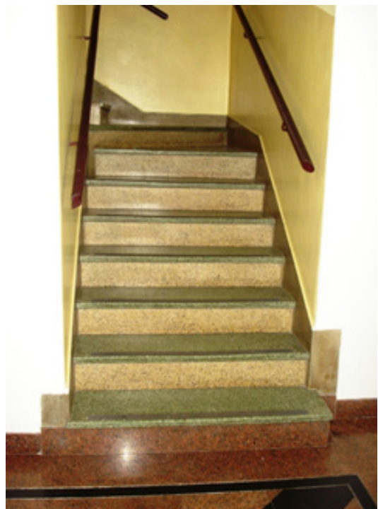
Imagem 178: Piso da escada do hotel e rodapés em granitina nas cores verde (piso) e bege (espelho e rodapé) e guarda-corpo em metal tubular. Fonte: Daniella Medeiros Rocha, 2012.
