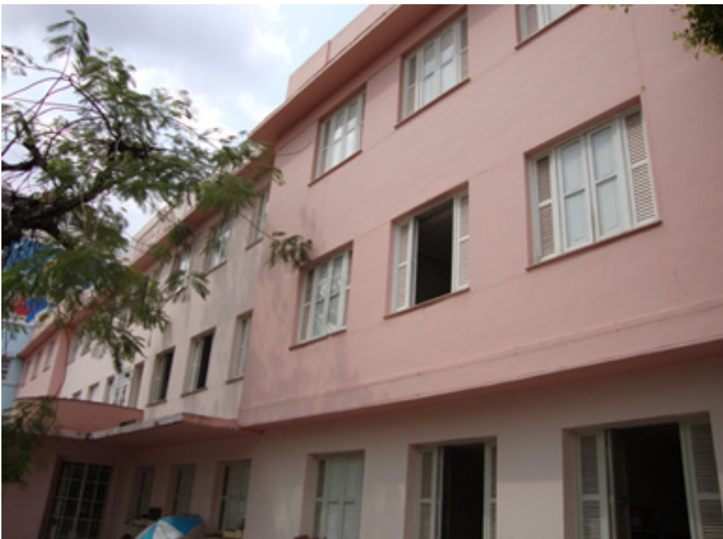
Imagem 112: Esquadrias da fachada da Av. Goiás. Fonte: SEINFRA, 2012.
