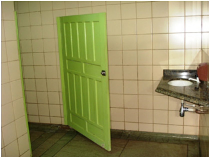
Imagem 78: Sanitário para Portadores de Necessidades Especiais. Fonte: Daniella Moreira Rocha, 2013.
