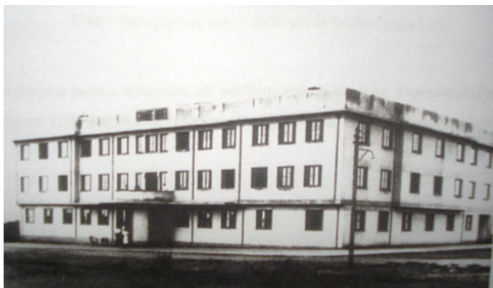
Imagem 102: Edifício executado em 1937, com alterações do projeto original. Fonte: Secretaria de Planejamento.
