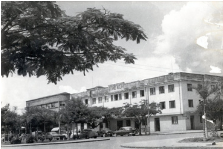
Imagem 105: Fachada Grande Hotel, abertura de duas portas na lateral direita do térreo, década de 1940. Fonte: Arquivo Hélio de Oliveira.
