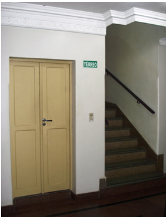
Imagem 177: Porta do poço do elevador e escada de acesso aos pavimentos superiores. Fonte: Daniella Medeiros Rocha, 2012.
