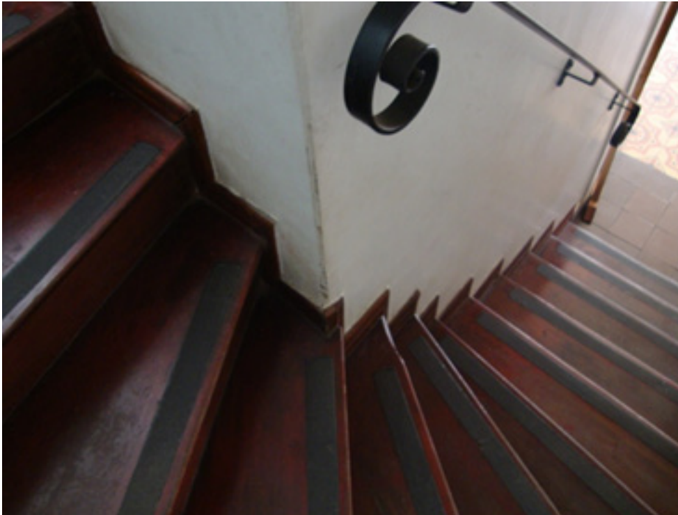
Imagem 121: Corrimão da escada original do Grande Hotel, em 2012. Fonte: SEINFRA.
