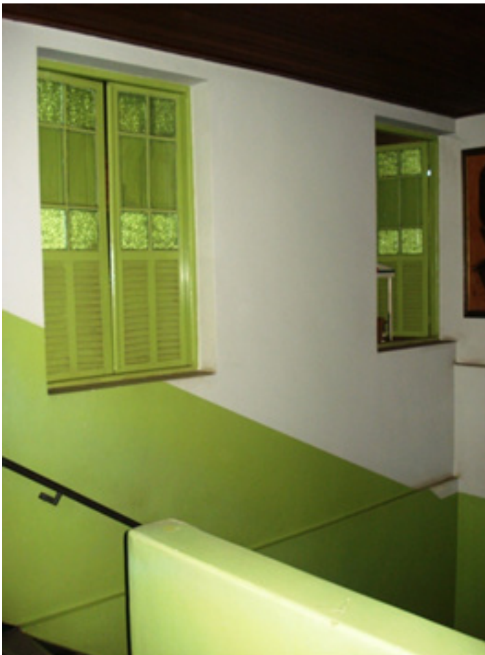
Imagem 66: Janelas de madeira voltadas para o vão da escada no piso superior. Fonte: Daniella Moreira Rocha, 2013.
