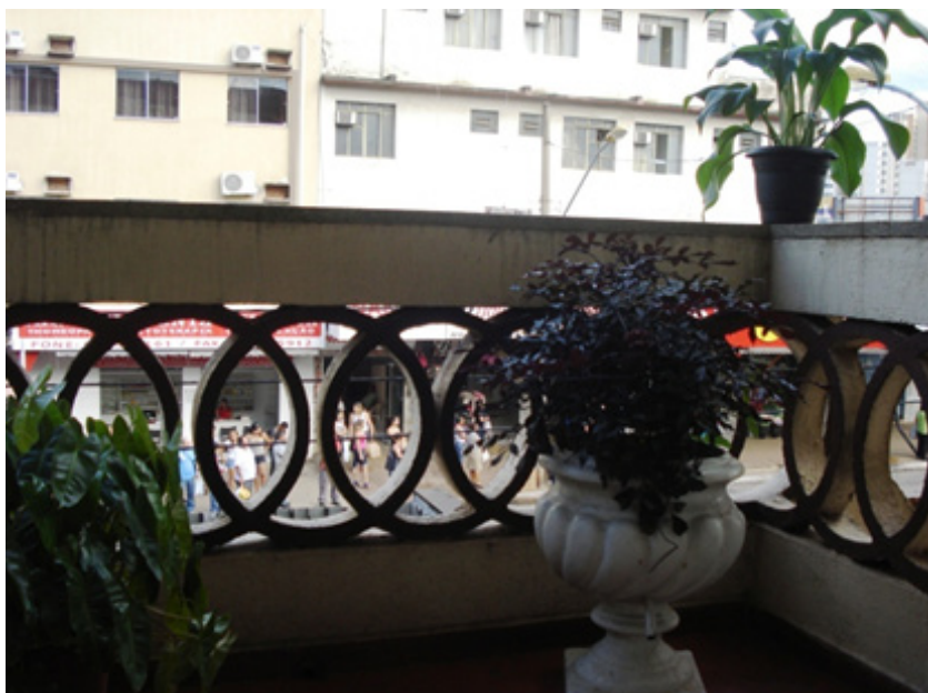
Imagem 184: Detalhe da sacada em frente à sala de convívio no 1º piso. Fonte: Daniella Moreira Rocha, 2012.
