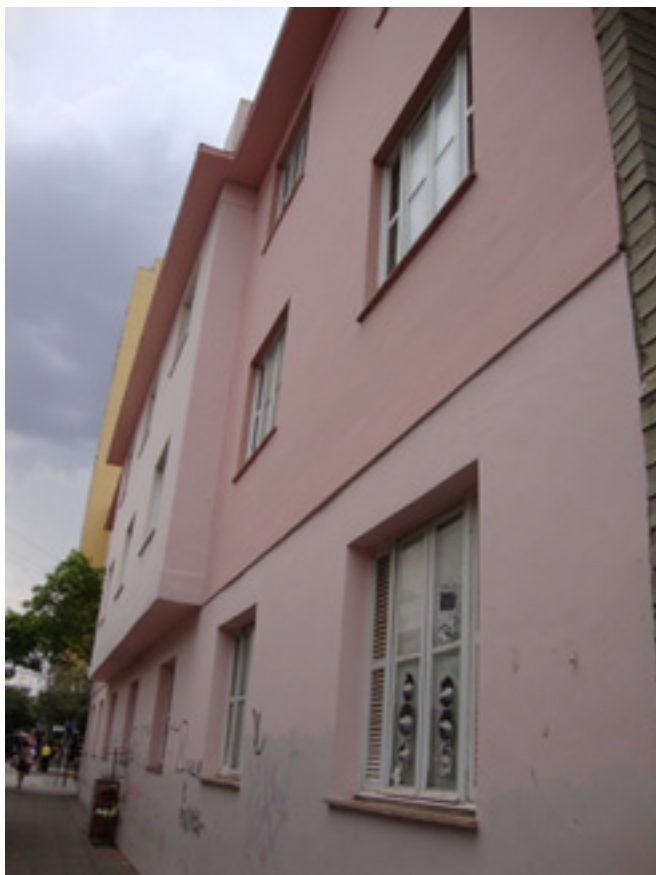
Imagem 113: Esquadrias da fachada da Rua 03. Fonte: SEINFRA, 2012.
