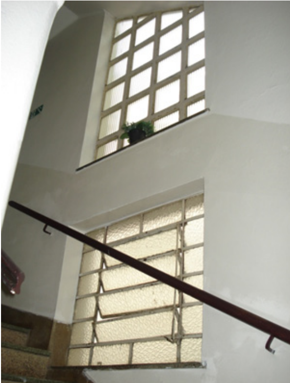
Imagem 179: Esquadria basculante de ferro com vidro martelado e janela de vidro fixo canelado no hall da escada.
