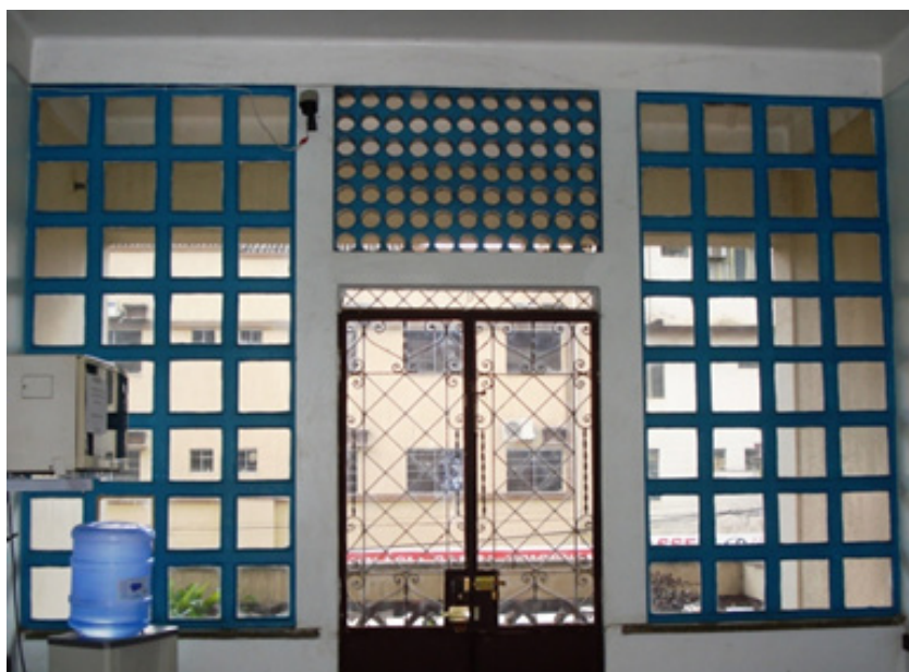
Imagem 182: Painel em alvenaria, metal, madeira, vidro e concreto. Fonte: Daniella Moreira Rocha, 2012.
