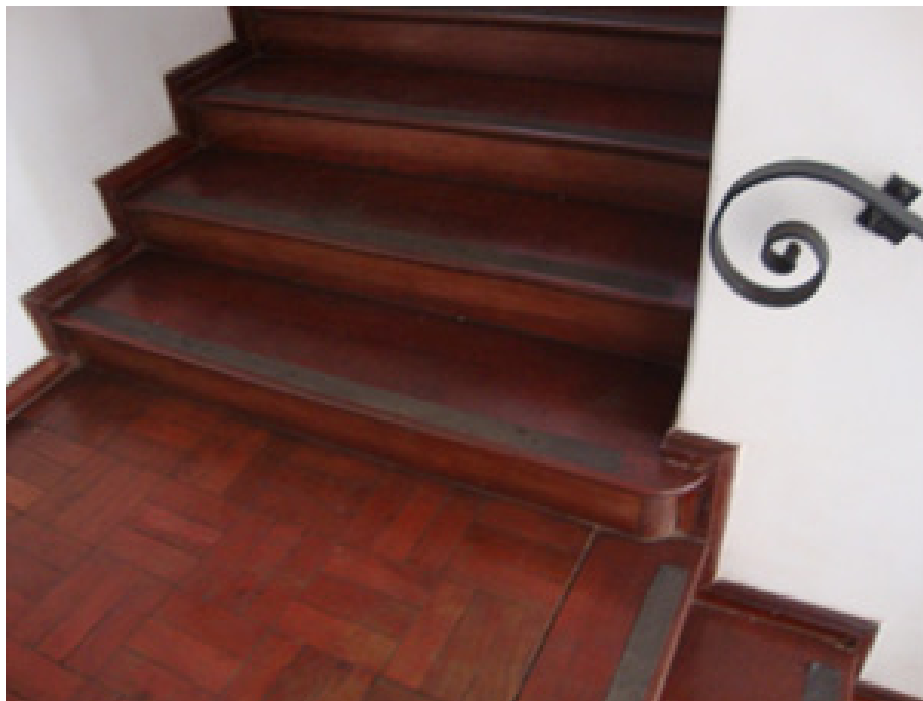
Imagem 119: Piso da original da escada do Grande Hotel, em 2012. Fonte: SEINFRA.
