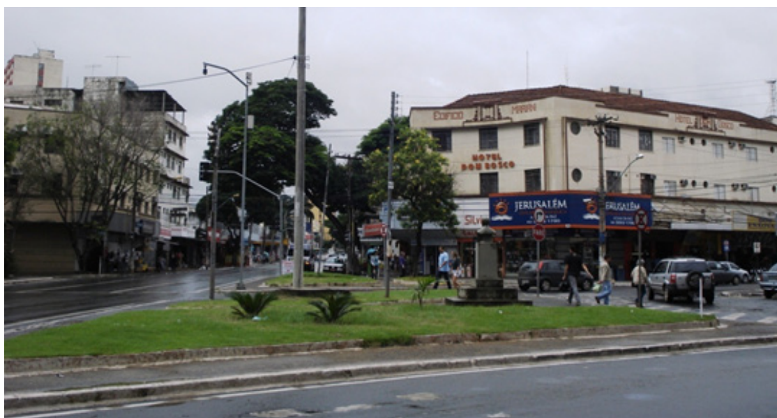
Imagem 156: Edifício do Hotel Dom Bosco em frente à Praça Antônio Lisita, Araguaia eq. c/ Rua 04. Fonte: Daniella Moreira Rocha, 2013.
