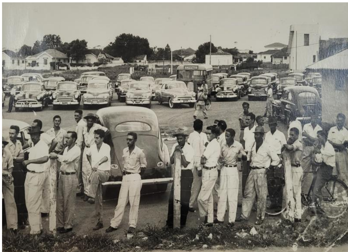
Figura 10 - Estacionamento do Aeroporto, à direita Estação Meteorológica.
