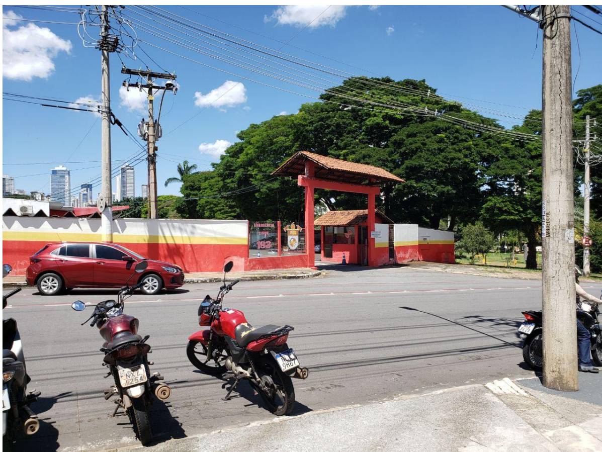
Figura 48 - Antiga Estação Rodoviária que hoje é sede do Corpo de Bombeiros.
