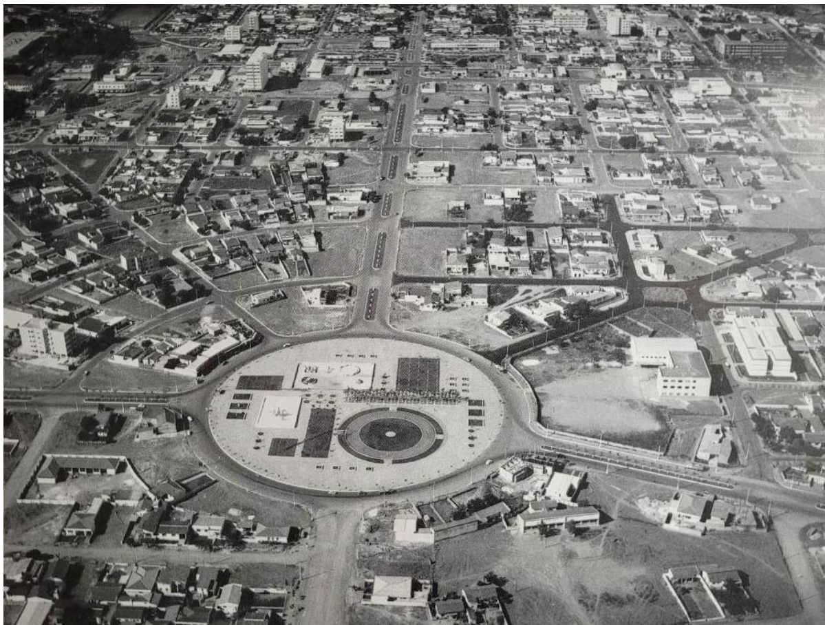
Figura 25 - Praça do Avião já urbanizada em 1969.
