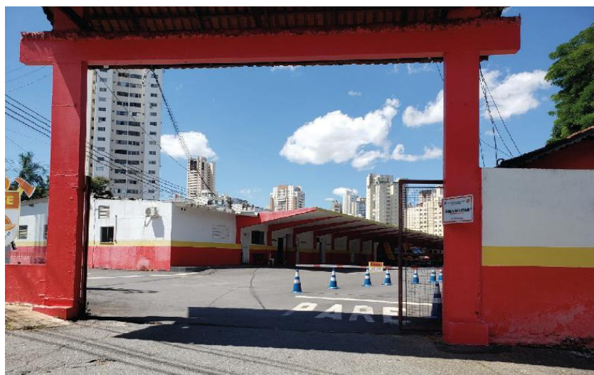
Figura 80 - Entradas do corpo de bombeiros, restritas à funcionários.
