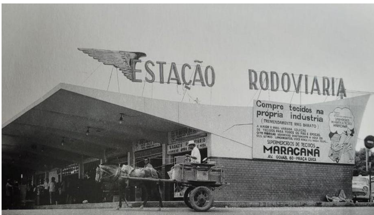
Figura 42 - Cobertura curva e em balanço da Estação Rodoviária, 1962.
