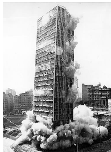
Figura 16 - Implosão do Edifício Wilson Mendes Caldeira, 1975. Fonte: encurtador.com.br/esxX2 , 2021
