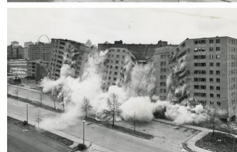
Figura 15 - Demolição do Conjunto Pruitt-Igoe, em 1972. Fonte: encurtador.com.br/biDQ4 , 2020
