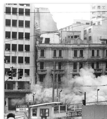
Figura 17 - Palacete Tina e Ed. Irmãos Cozo demolidos em São Paulo, 1976. Fonte: encurtador.com.br/zAJQZ , 2021
