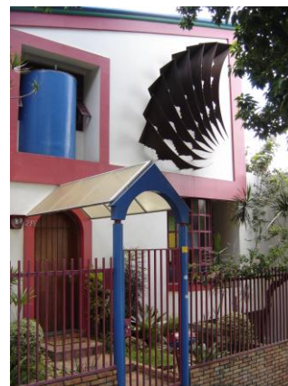
Figura 49 – Residência Eurípedes e Telma, 1983. Fonte: Acervo Jô Vasconcellos
