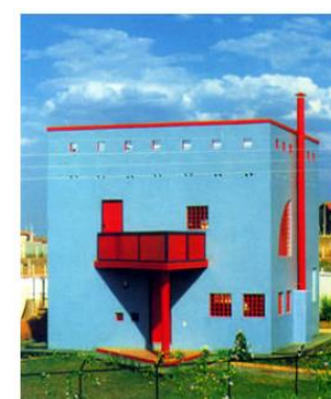
Figura 101 - Casa Cícero, DF. Fonte: Acervo Jô Vasconcellos
