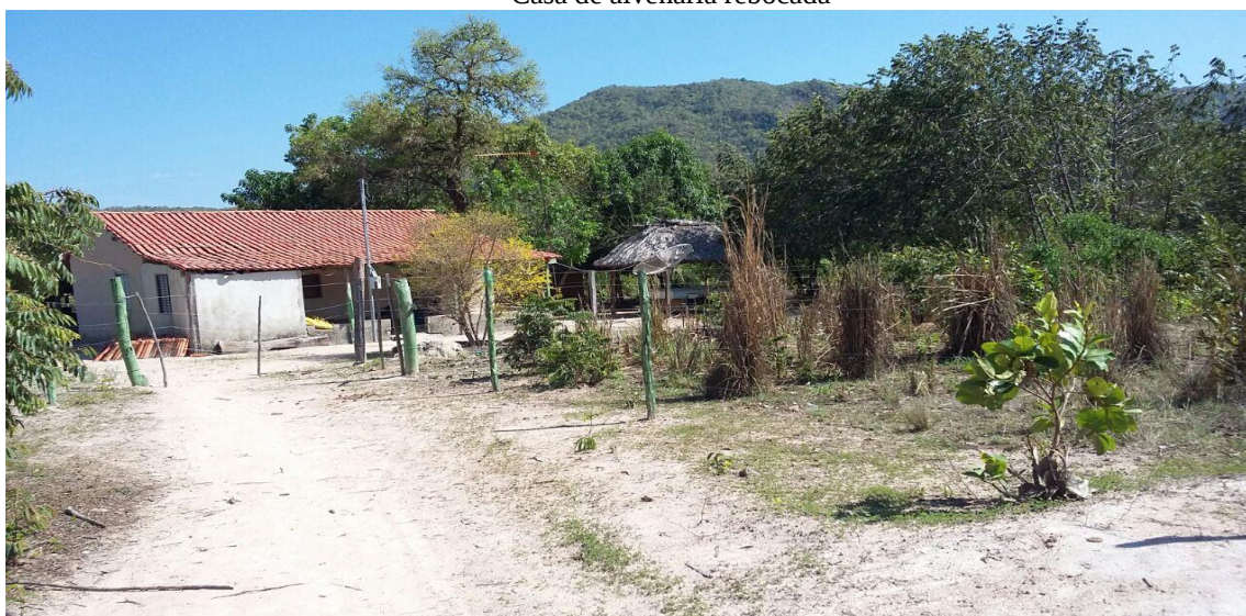
Imagem Nº012 Casa de alvenaria rebocada
