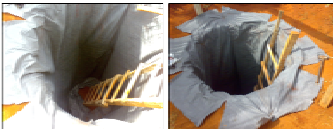
Figura 3.13 – Execução do poço de infiltração
