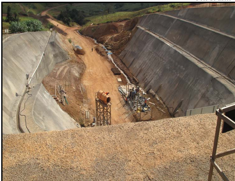
Figura 24 – Obra do túnel da Ferrovia Norte-Sul
