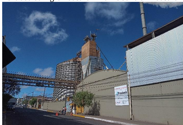
Figura 30b - Placa do PRODUIR colocada na entrada da Agroindústria – Bairro Jundiáí Industrial
