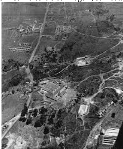
Figura 19a - Vista aérea da Vila Fabril com frigorífico no centro da imagem, sem data
