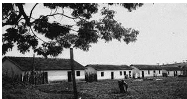
Figura 19b - Instalações do frigorífico na Vila Fabril
