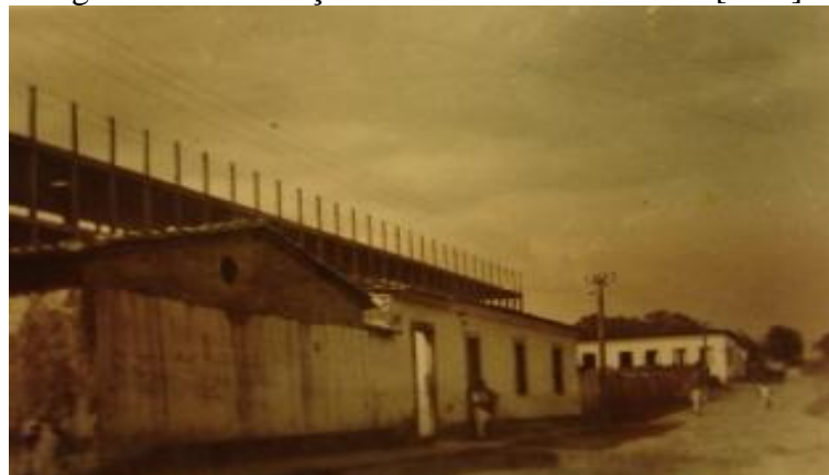
Fotografia 6. Construção do novo edifício da EIC [195-]
