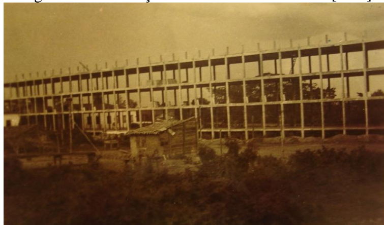
Fotografia 7. Construção do novo edifício da EIC [195-]
