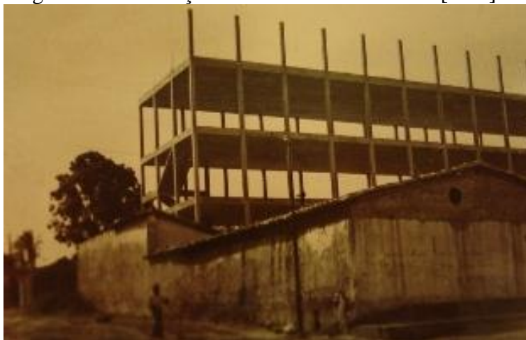
Fotografia 5. Construção do novo edifício da EIC [195-]
