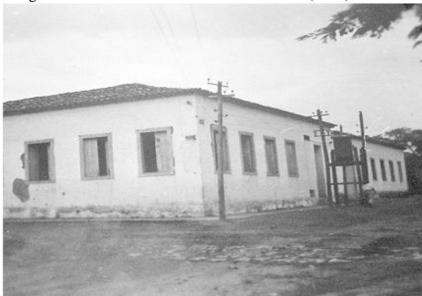
Fotografia 4 - Pavilhão das oficinas da EAAMT (1937).
