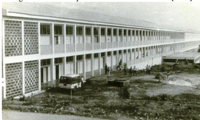
Fotografia 8. Construção do novo edifício da EIC [195-]
