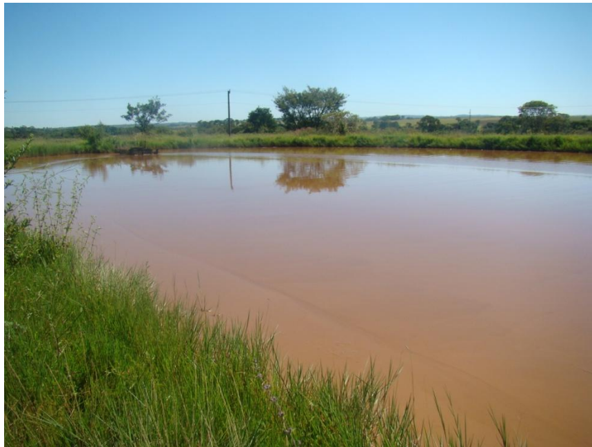
Figura 6 - Lagoa de lodo que está recebendo os resíduos provenientes dos decantadores e filtros da ETA.
