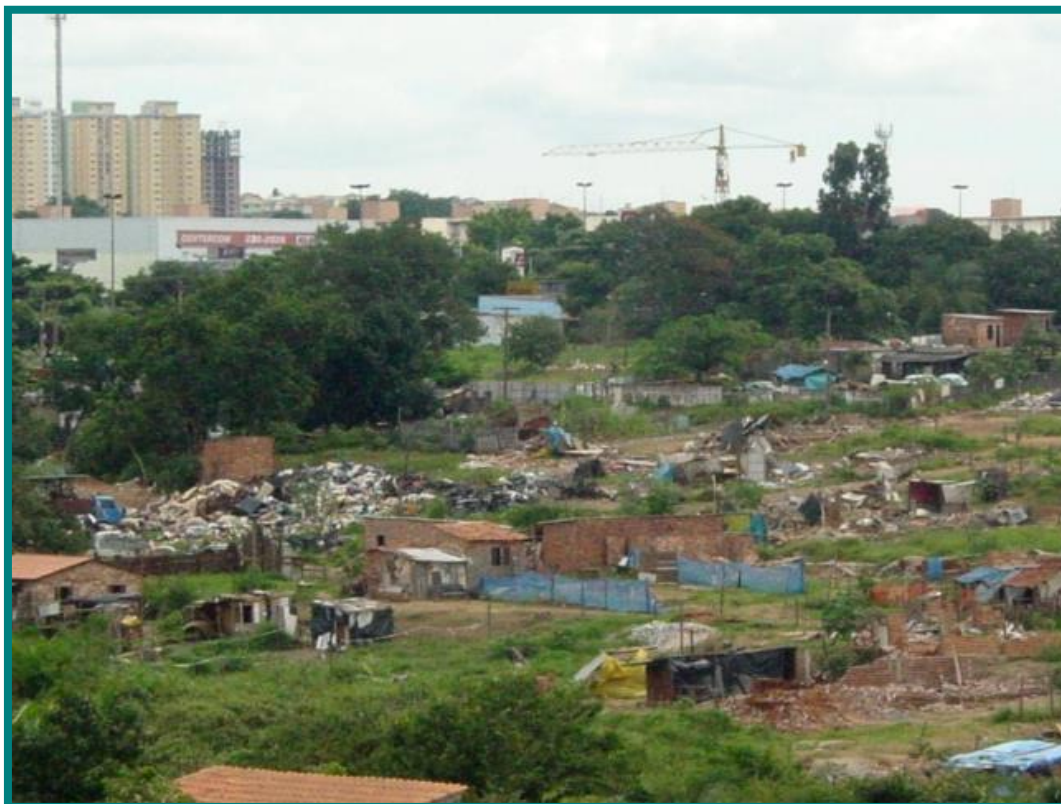
Figura 16 - Foto da demolição em contraste com a verticalização
