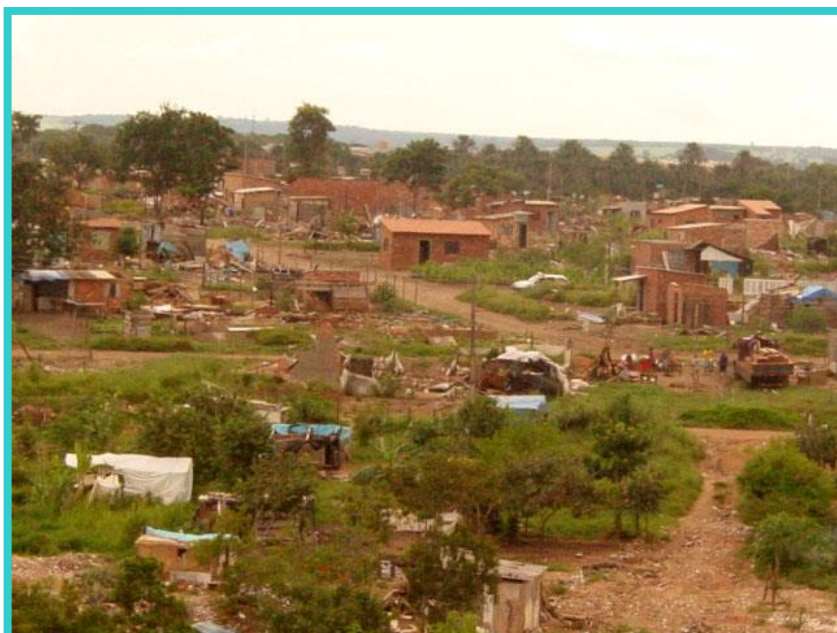
Figura 15 - Foto - A demolição do “Sonho”
