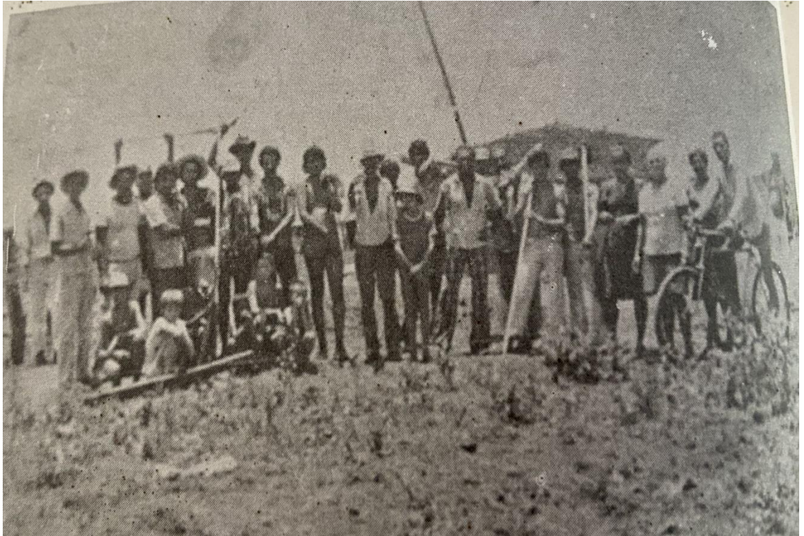
Imagem 5: 30 Demarcação e abertura das ruas do Jardim Nova Esperança.
