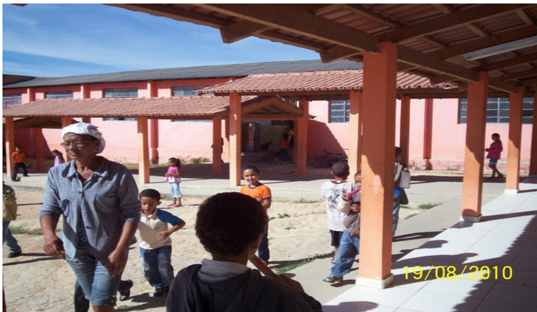
Fotografia 2. Vista interna do Colégio Municipal Alcy Alves Moreira.
