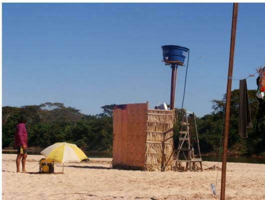
Foto xiii: sanitário de acampamento de conforto médio e estrutura rústica. Único sanitário com captação de águas
