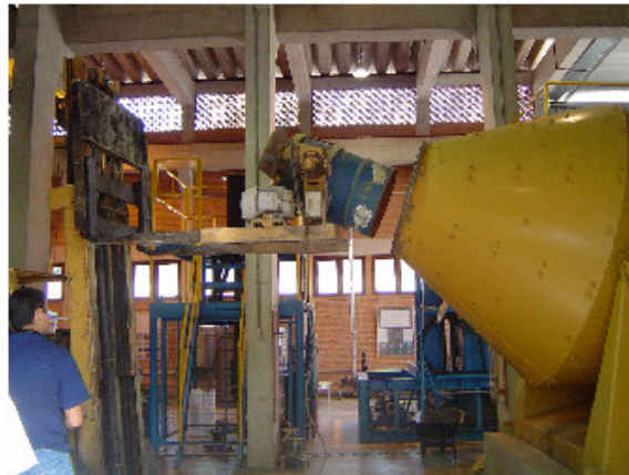
Foto 4.2 – Colocação dos materiais na betoneira.
