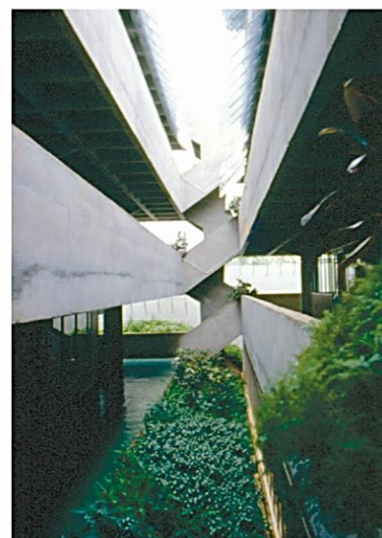
73. Articulação dos meio-pisos no edifício do IBDF. Fonte: foto do acervo particular do arquiteto Eduardo Simões Barbosa.
