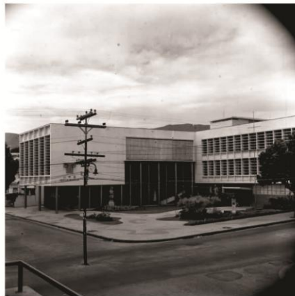
23. Escola de Arquitetura de Minas Gerais (1954). Fonte: Coleção arquitetura e cidade.
