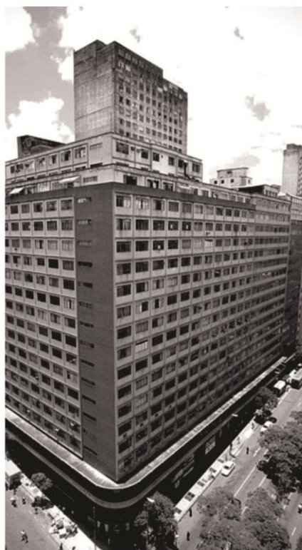
24. Edifício Arcângelo Maletta (1957). Fonte: skyscrapercity.
