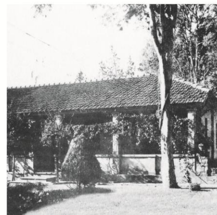
25. Primeira instalação: Parque Municipal de Belo Horizonte (1930-1937). Fonte: Escola de Arquitetura UFMG.
