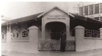
28. Quarta instalação: Prédio do Mercadinho. Escola sendo erguida ao fundo. Fonte: Escola de Arquitetura UFMG.
