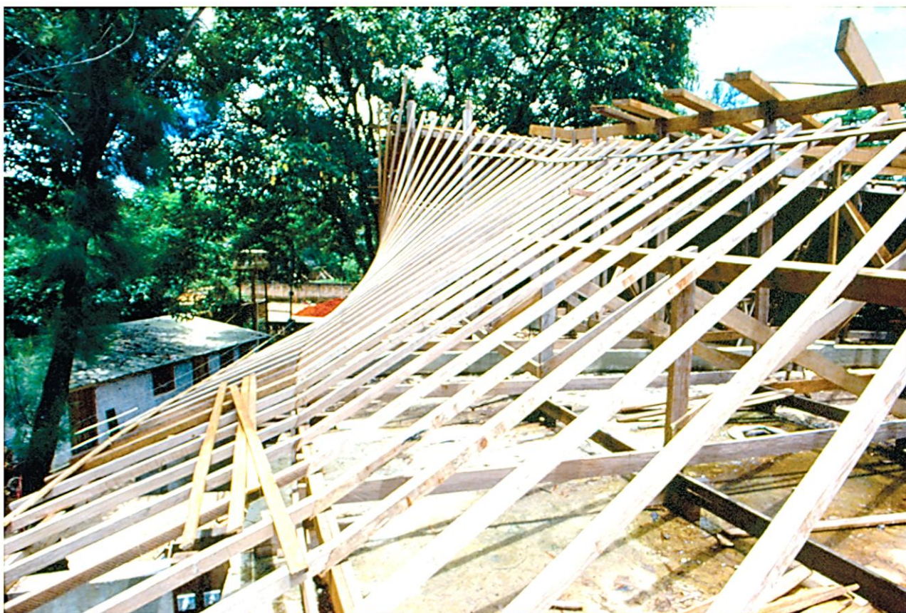
70. Madeiramento do telhado da Residência Aldi Alves Bezerra. Fonte: fotos do acervo particular do arquiteto Eduardo Simões Barbosa.
