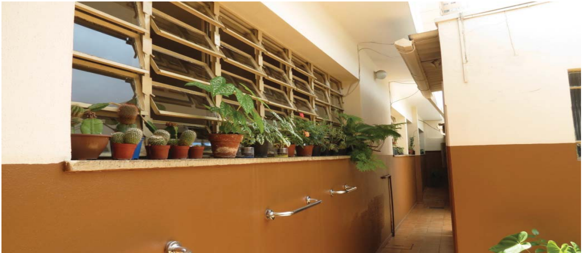
Figura 56 - Vista da parte externa da copa/ construção da nova cozinha (lado esquerdo da imagem). Fonte: Isabela Menegazzo, setembro de 2012.
