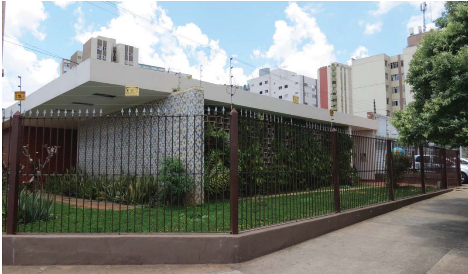
Figura 15 - Elevação Rua 09 em outubro de 2012. Fonte: Isabela Menegazzo, 20/10/2012
