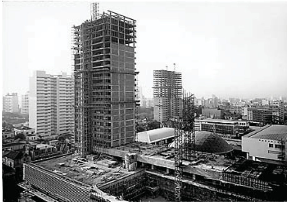
Figura 9 - Foto: Construção do Conjunto Nacional, SP, 1954. Fonte: BRASIL, 2007.
