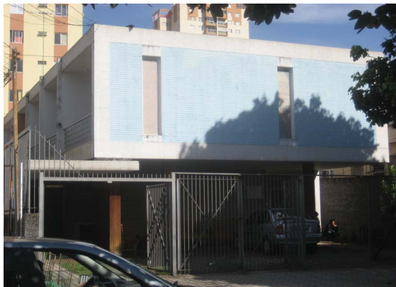
Figura 6 - Vista da casa com elevação para Alameda Botafogo. Fonte: Neto, 2010
