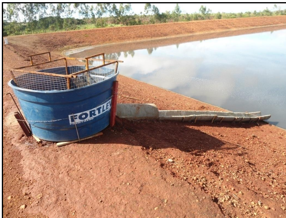
Figura 17 - Aparato experimental instalado no talude da lagoa anaeróbia receptora
