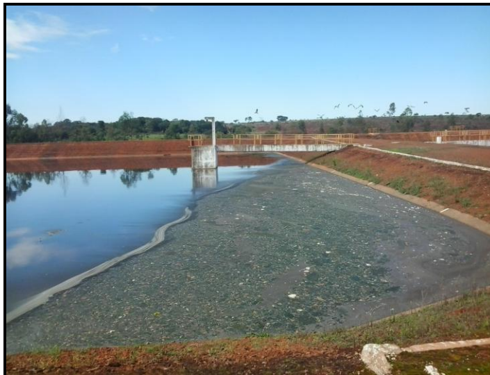
Figura 15- Escuma formada na lagoa anaeróbia receptora
