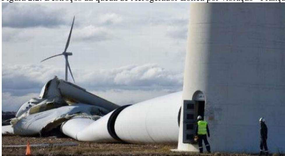
Figura 2.2: Destroços da queda de Aerogerador Eólica por vibração –França.
