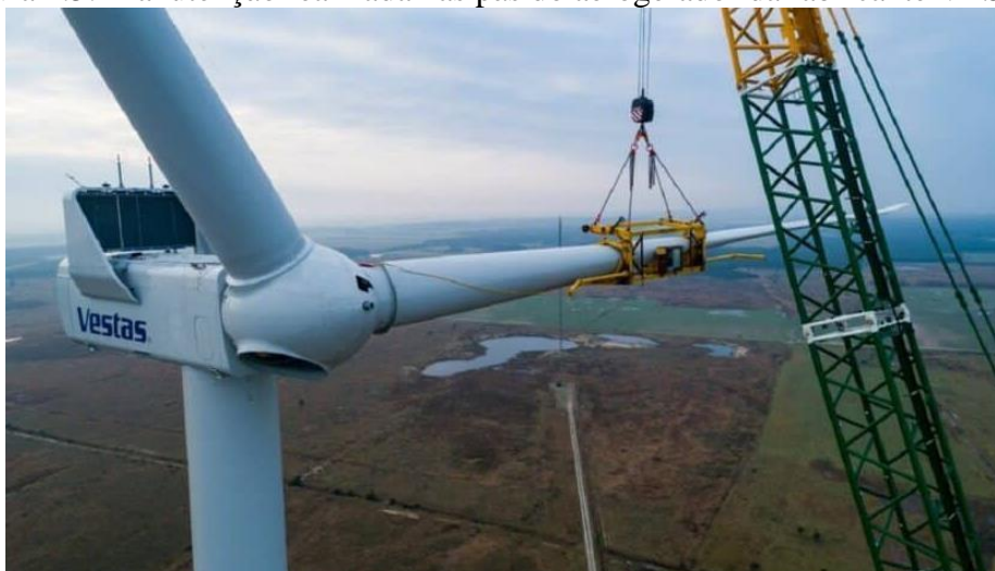
Figura 1.5: Manutenção realizada nas pás do aerogerador da fabricante VESTAS.
