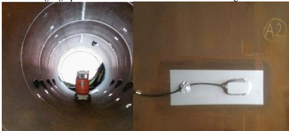
Figura 2.24: Strain gauge posicionado no interior da torre de um aerogerador em construção.
