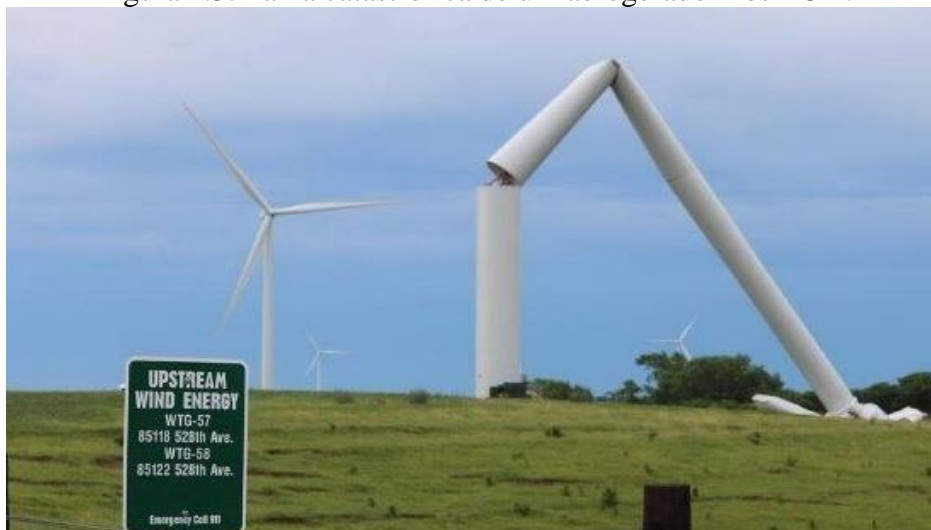
Figura 2.3: Falha catastrófica de um aerogerador nos EUA.
