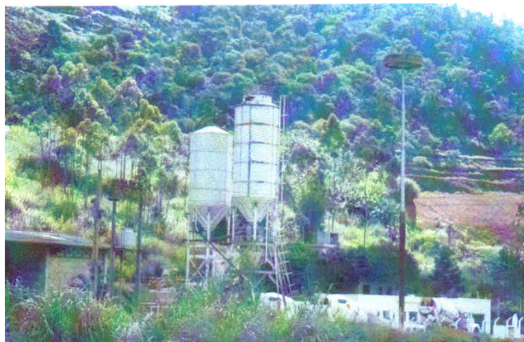
Figura 1.2 – Vista parcial de uma concreteira na região de Juiz de Fora, podendo-se notar a presença de dois silos de aglomerantes, um CP V ARI RS e o outro de escória de alto-forno (POLISSENI, 2005).
