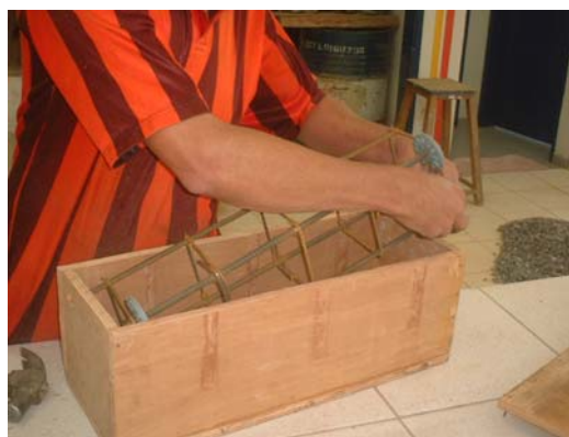
FIGURA 5.3 – Armadura com os espaçadores.
