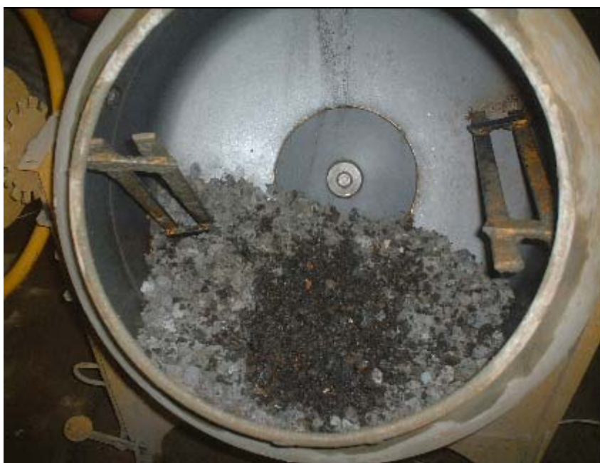
FIGURA 5.11 – Mistura dos materiais na betoneira: agregado graúdo (brita – micaxisto, escória de aciaria elétrica ou ambos), parte da água junto com o plastificante, quando necessário.
