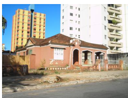
Figura 04: Foto: Residência (Rua 20, Setor Central). Fonte: Márcia Araújo 2007.
