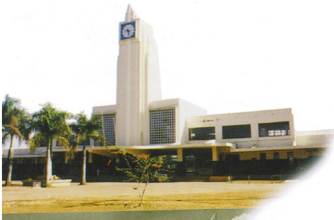
Figura 19 – Foto. Estação Ferroviária (Áreas entre as Avenidas Independência, Oeste e Contorno). Fonte: Manso 2004, v. II, p. 48
