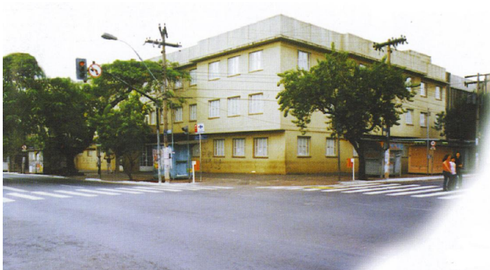
Figura 16 – Foto. Grande Hotel (Av. Goiás, esquina com rua 3, Setor Central). Fonte: Manso 2004, v.II, p. 42.
