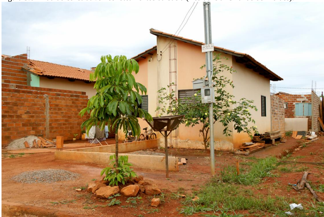
Figura 3.6 – Padrão construtivo nos loteamentos da bacia (Residencial Orlando de Moraes).
