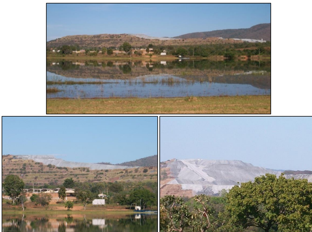
Três perspectivas da bancada de rejeitos de amianto (parcialmente vegetada)
