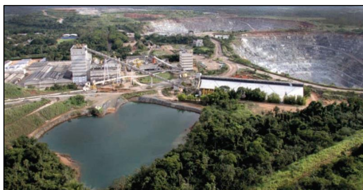
Vista aérea da área industrial da SAMA e da mina de Cana Brava Fonte: Relatório de Sustentabilidade SAMA (2013, p. 51).
