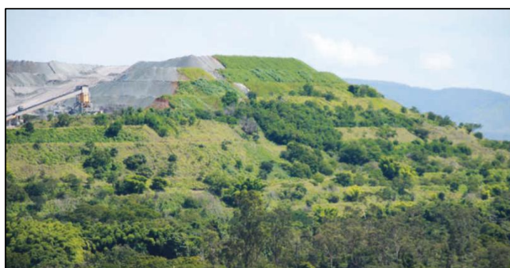
Bancada de rejeitos do processo de beneficiamento do amianto crisotila Fonte: Relatório de Sustentabilidade SAMA (2013, p. 95).
