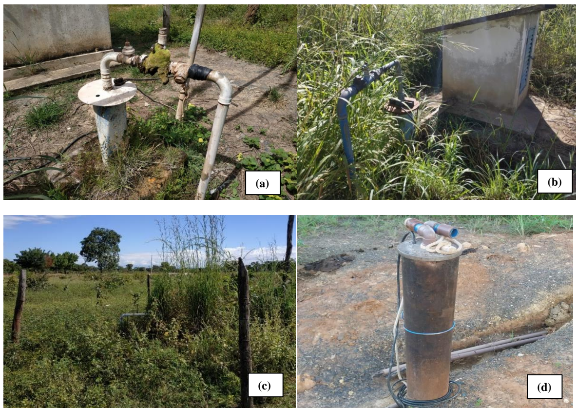
Figura 15 – Representação do poço tubular profundo do SAA1 (a), SAA2 (b), SAA3 (c) e SAA4 (d) da Comunidade de Canabrava.
