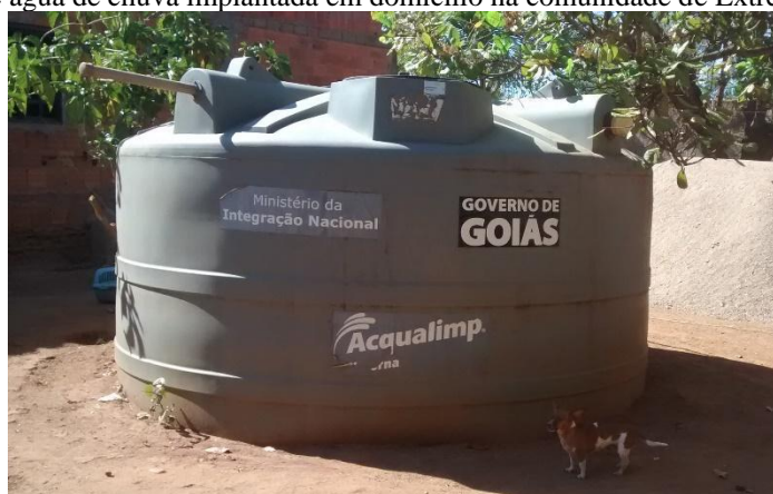
Figura 23 – Cisterna de água de chuva implantada em domicílio na comunidade de Extrema.
